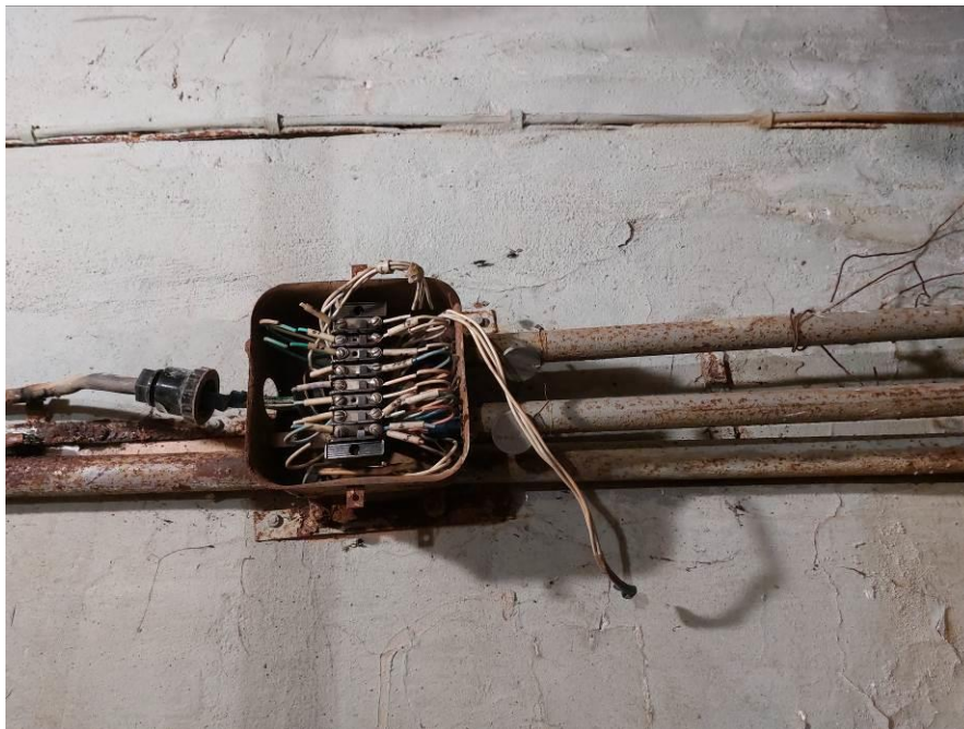
Фото 176. ЦИК, подвал, коррозия трубопроводов, оголенные провода.
