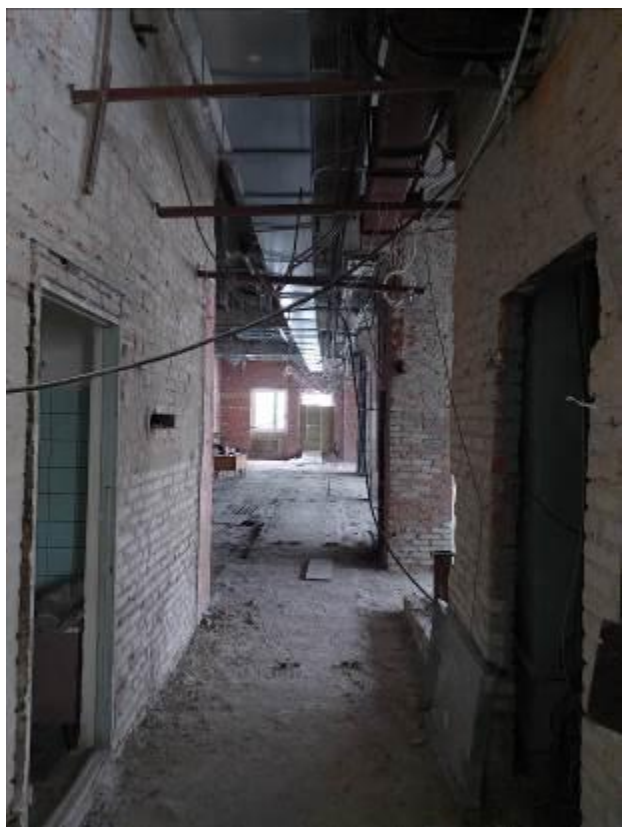
Фото 77. Пристройка ЦИК, 2 этаж, кабели демонтированы, отключены, короба вентиляционные обрезаны.
