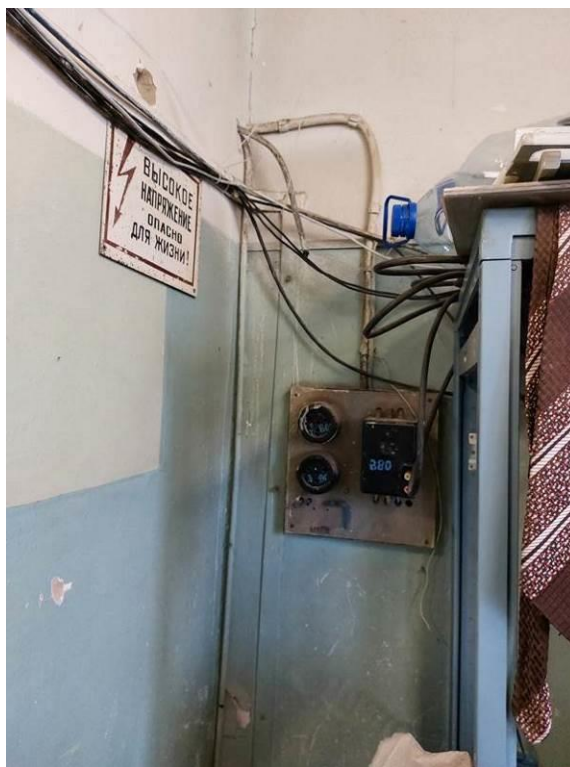
Фото 126. ЦИК, 2 этаж, система электроснабжения, выполнена с нарушением ПУЭ.
