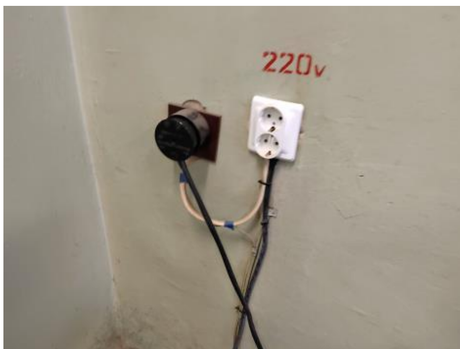
Фото 113. Пристройка ЦИК, 1 этаж, электропитание новых розеточных групп осуществляется от розеточной сети 220В, кустарным способом в нарушении ПУЭ.
