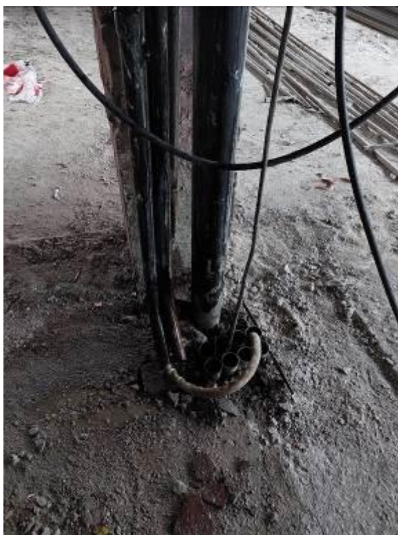
Фото 76. Пристройка ЦИК, 2 этаж, стояк системы ливневой канализации, силовой электрической сети, кабели демонтированы, отключены.
