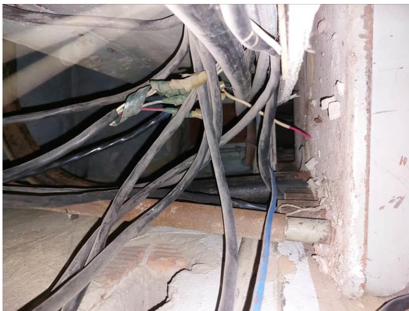
Фото 170. ЦИК, подвал, кабельные трассы, отсутствие кабельных бирок, скрутки.
