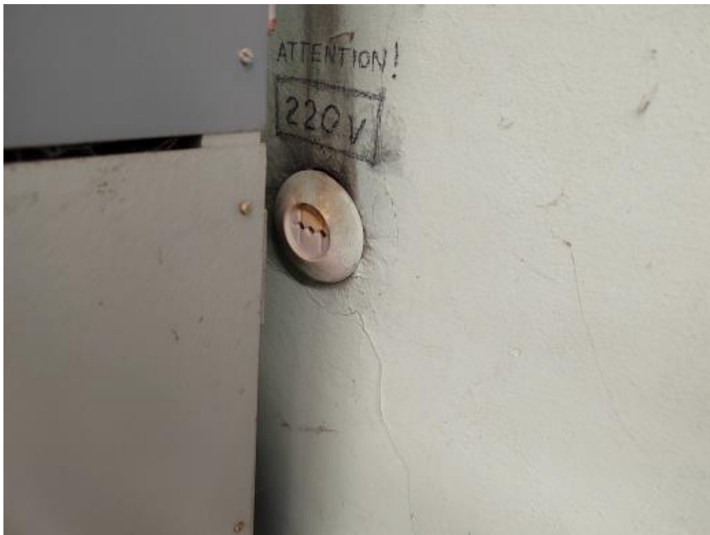
Фото 116. Пристройка ЦИК, 1 этаж, следы возгорания розеточных групп.
