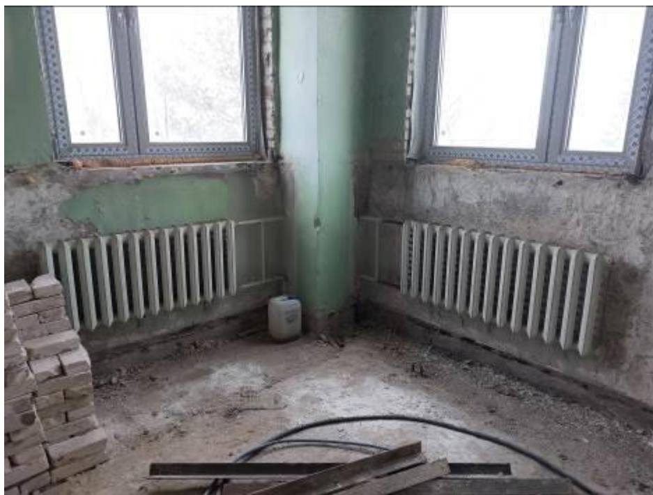
Фото 37. Пристройка ЦИК, 4 этаж, система отопления, коррозия трубопроводов, следы протечек, отсутствие запорно-регулирующей арматуры, имеющаяся запорно-регулирующая арматура в неработоспособном состоянии.
