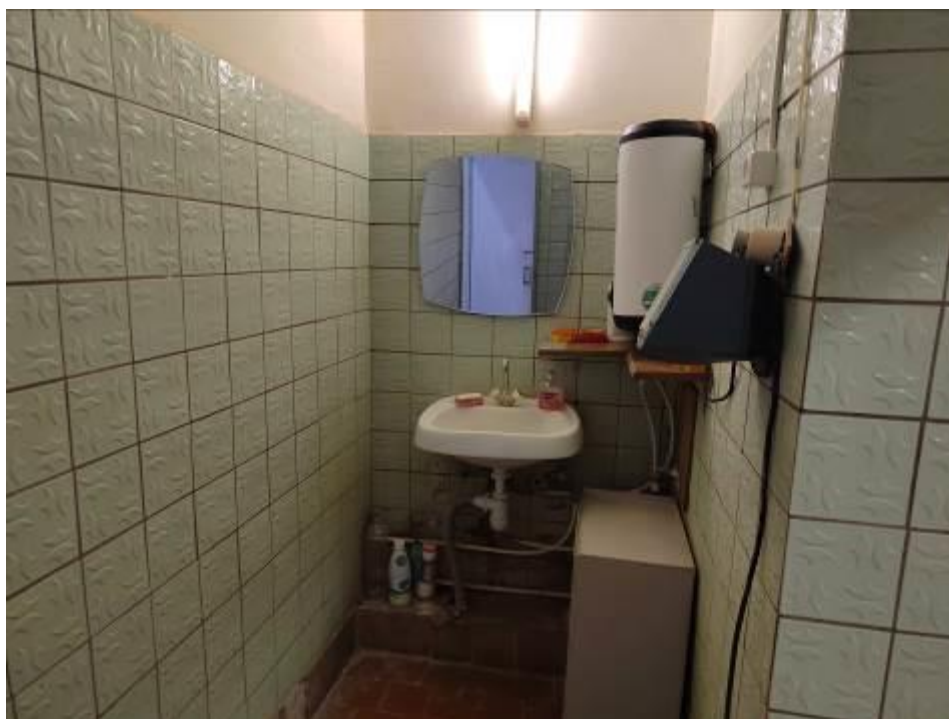
Фото 60. Пристройка ЦИК, 3 этаж, санитарный узел, электрика в ограниченно работоспособном состоянии, водоснабжение и канализация.
