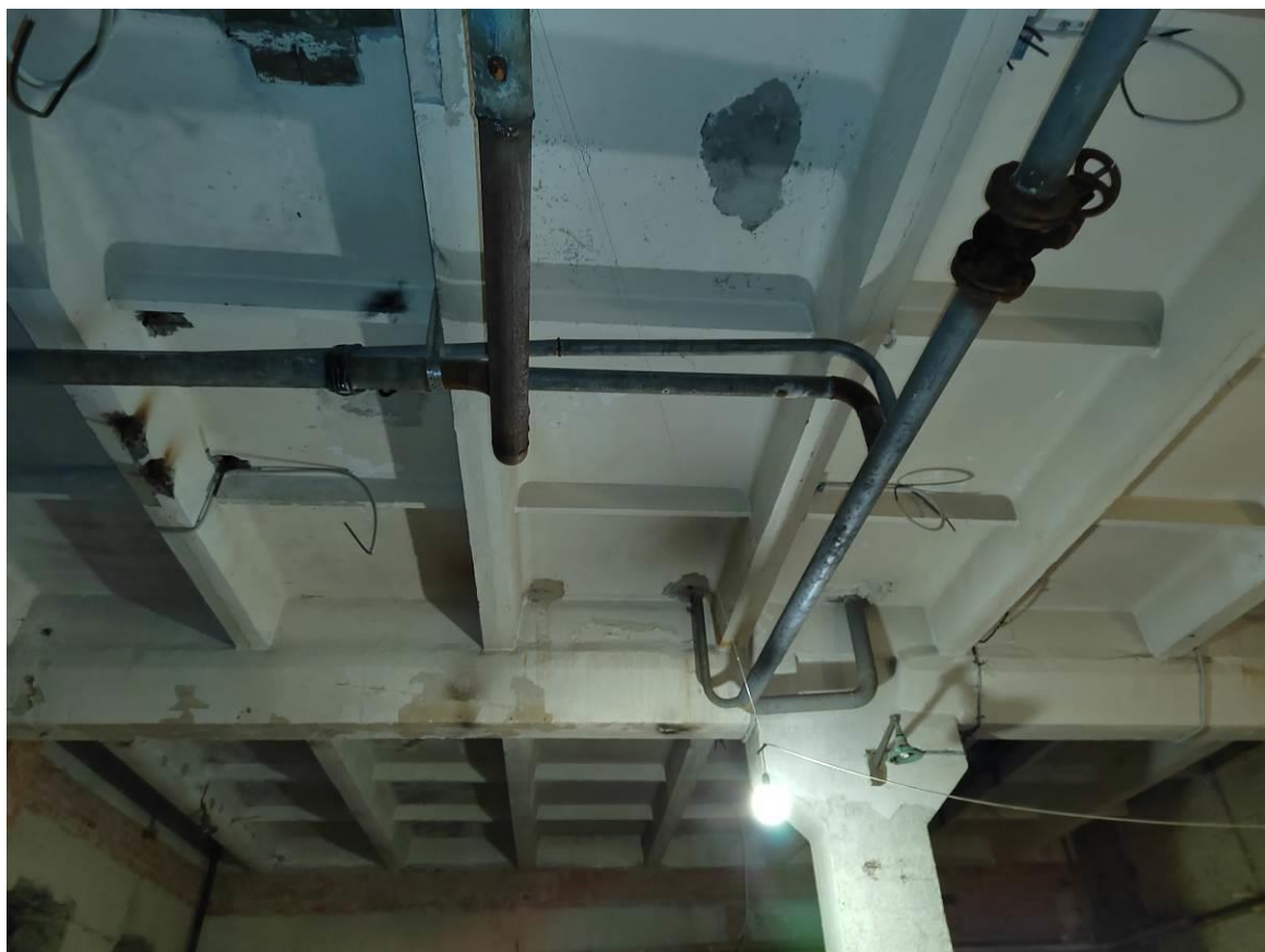
Фото 193. Пристройка к ЦИК, подвал, системы водоснабжения и ливневой канализации, коррозия трубопроводов и запорно-регулирующей арматуры.
