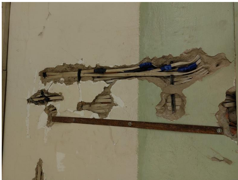
Фото 141. ЦИК, 2 этаж, прокладка кабеля в штукатурном слое.
