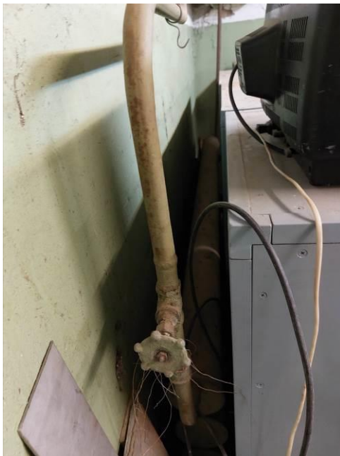
Фото 162. ЦИК, подвал, сплошная коррозия трубопроводов теплоснабжения, не рабочая запорно-регулирующая арматура.
