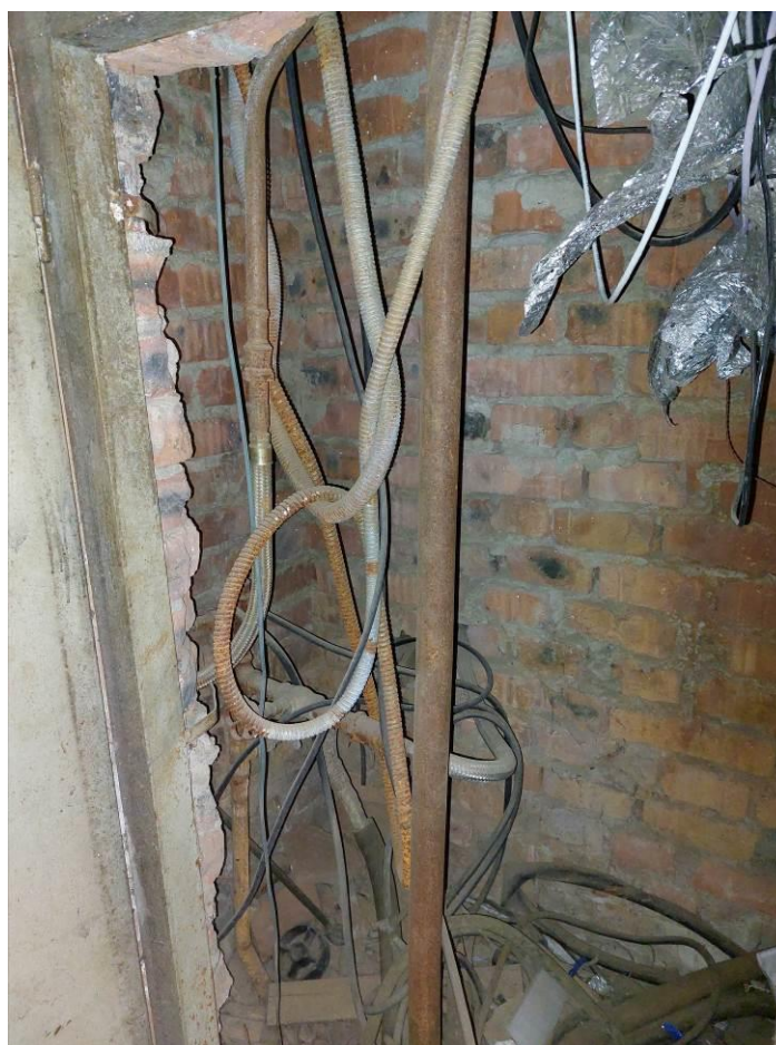
Фото 177. ЦИК, подвал, кабельный стояк, оголенные провода, коррозия изоляции.
