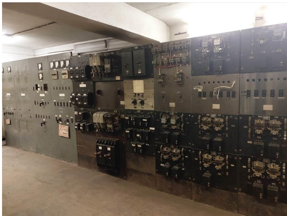
Фото 181. ЦИК, подвал, частично разукomплектованные, частично не рабочие секции ВРУ.
