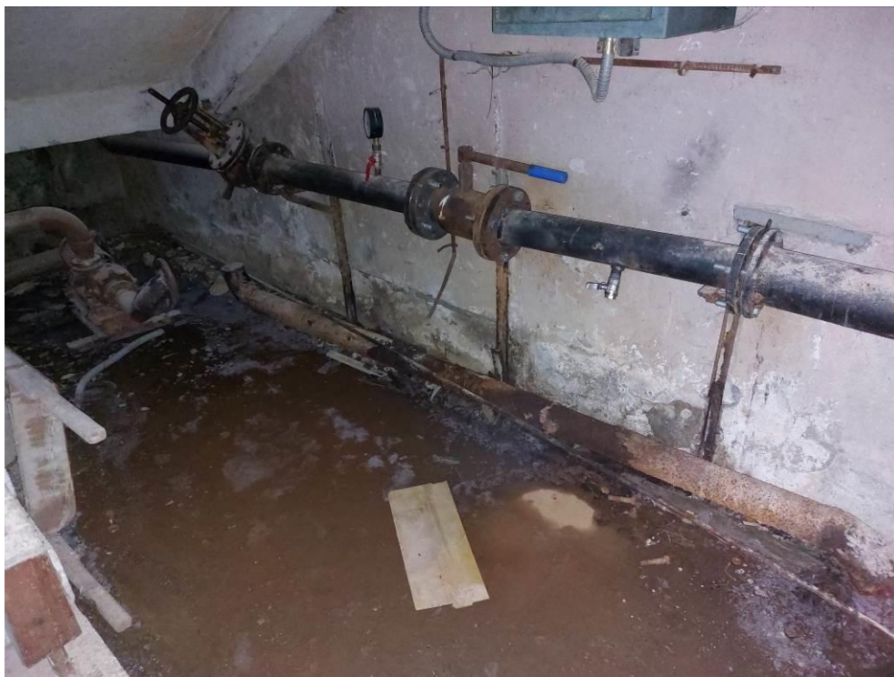
Фото 190. Пристройка к ЦИК, подвал, ввод холодного водоснабжения, коррозия запорно-регулирующей арматуры, отсутствие узла учета.
