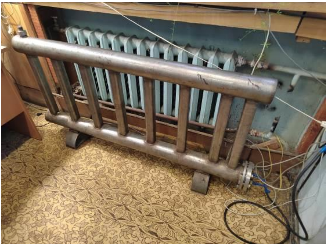
Фото 107. Пристройка ЦИК, 1 этаж, система отопления не работоспособна, установлен кустарный масляный радиатор, электропитание осуществляется от розеточной сети 220В.
