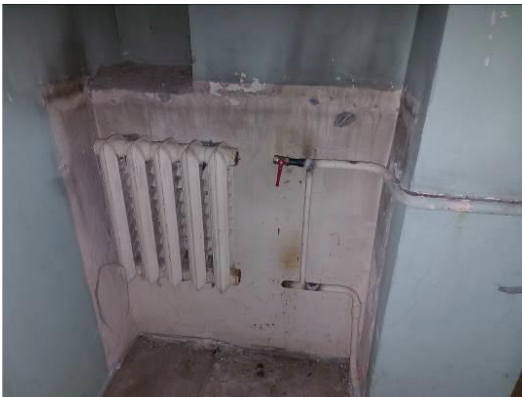
Фото 35. Пристройка ЦИК, 4 этаж, радиатор отопления отключен, подводки заглушены.
