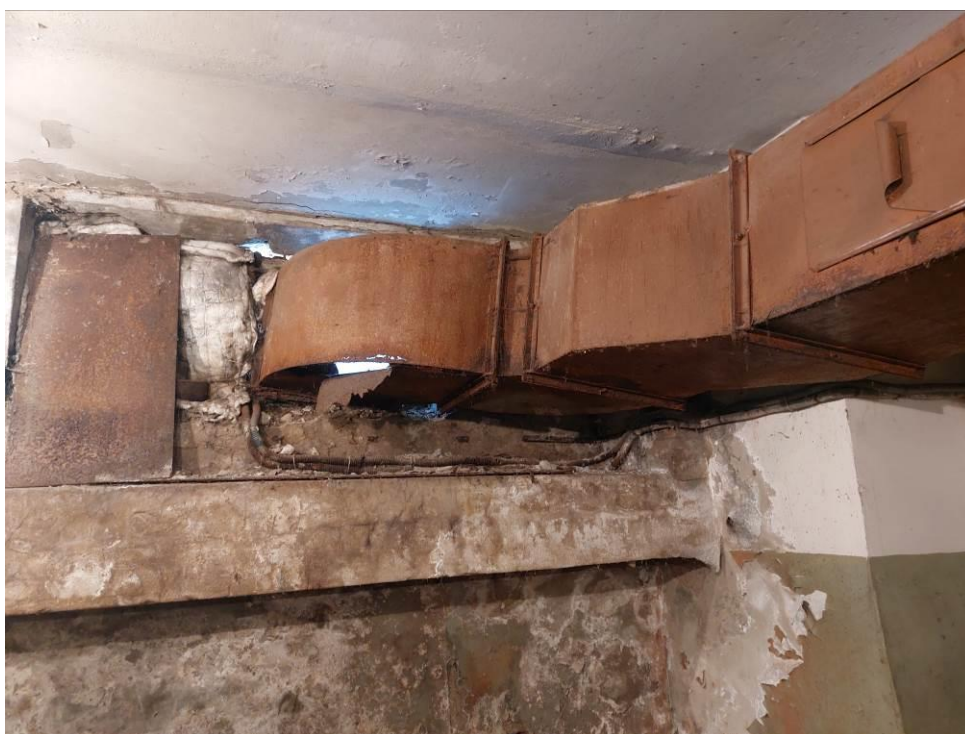
Фото 185. ЦИК, подвал, вентиляция, сплошная коррозия, разрушение воздуховодов.
