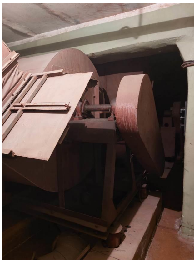
Фото 179. ЦИК, подвал, не рабочая установка приточной вентиляции.
