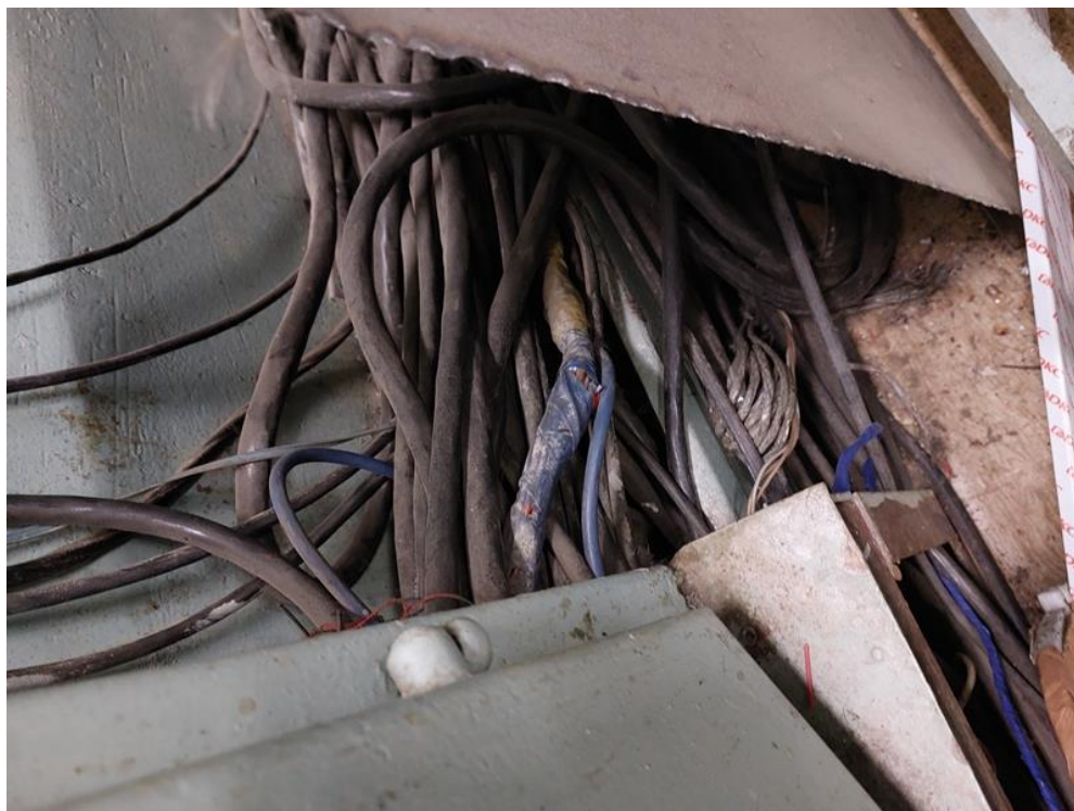
Фото 129. ЦИК, 2 этаж, кабельные трассы имеют повреждение изоляции, оголенные концы.
