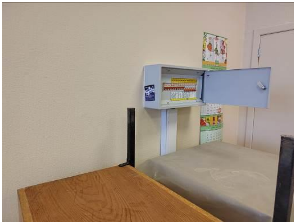
Фото 69. Пристройка ЦИК, 3 этаж, установлен новый распределительный щиток, подключение произведено старой кабельной линией, отсутствуют кабельные бирки.
