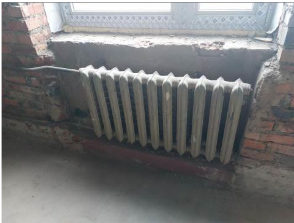
Фото 47. Пристройка ЦИК, 4 этаж, система отопления в ограниченно-работоспособном состоянии, коррозия трубопроводов, отсутствует или не исправна запорно-регулирующая арматура.
