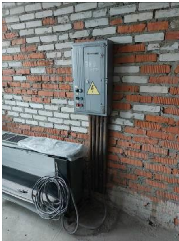
Фото 43. Пристройка ЦИК, 4 этаж, щит системы электроснабжения выведен из эксплуатации, частично разукomплектован.
