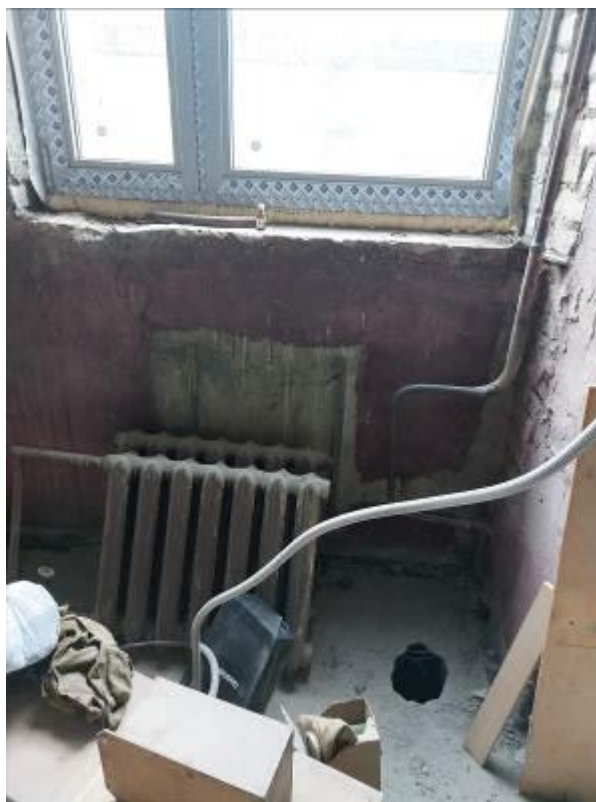
Фото 79. Пристройка ЦИК, 2 этаж, система отопления в ограниченно-работоспособном состоянии, радиатор демонтирован, выполнена закольцовка.
