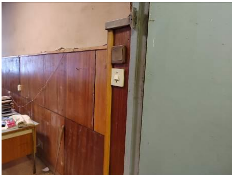
Фото 101. Пристройка ЦИК, 1 этаж, кабели систем электроснабжения и слаботочных сетей проложены в одном шлейфе, открыто по временной схеме, произведен дубляж систем освещения без демонтажа старой системы.
