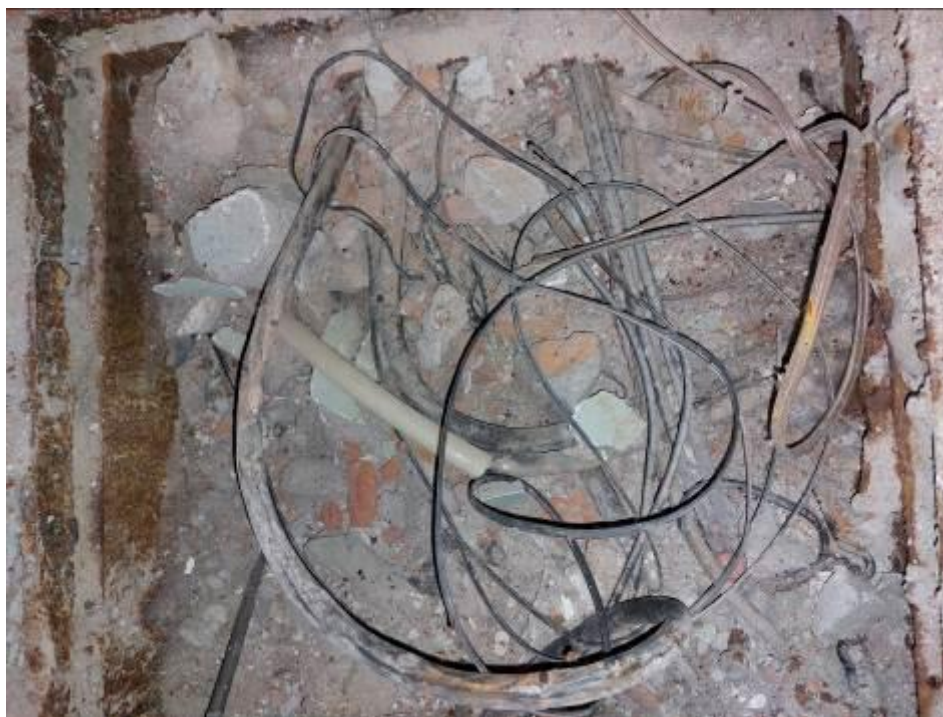
Фото 49. Пристройка ЦИК, 4 этаж, прямик электротехнический, обрезанные кабели, отсутствие маркировок кабеля.
