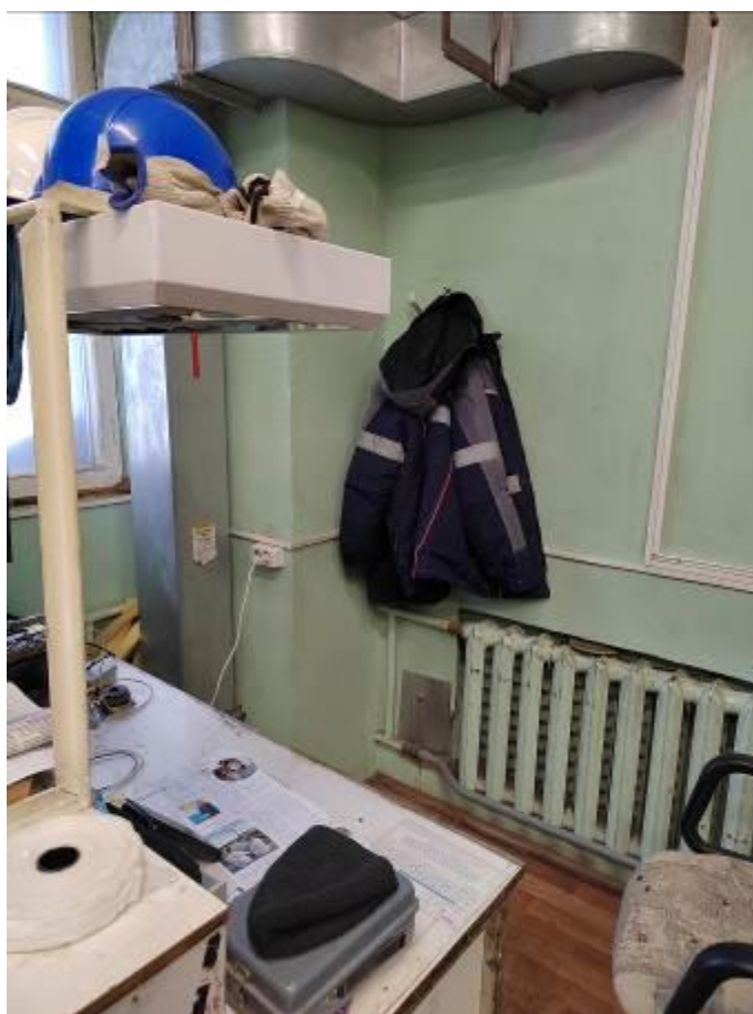
Фото 92. Пристройка ЦИК, 1 этаж, розетки силовые, местная вентиляция вытяжная с рабочего места, система отопления в ограниченно-работоспособном состоянии, следы протечек, байпас, отсутствует запорно-регулирующая арматура.
