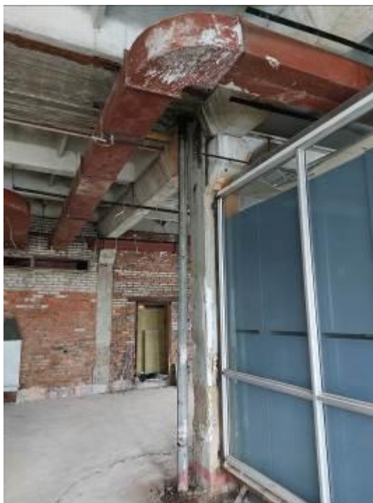
Фото 46. Пристройка ЦИК, 4 этаж, система ливневой канализации в ограниченно-работоспособном состоянии, система вентиляции в не работоспособном состоянии имеются следы потечек, сплошная коррозия вентиляционных коробов, следы протечек в месте выхода на кровлю.
