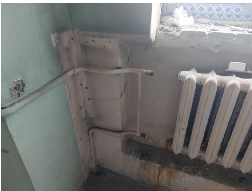
Фото 34. Пристройка ЦИК, 4 этаж, радиатор отопления отключен, подводки заглушены.
