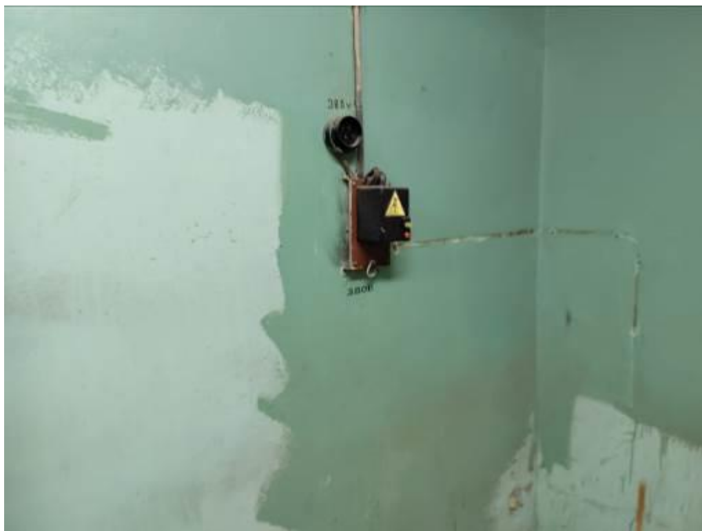
Фото 105. Пристройка ЦИК, 1 этаж, пульт запуска оборудования, маркировка и принадлежность отсутствует, выведен из эксплуатации.
