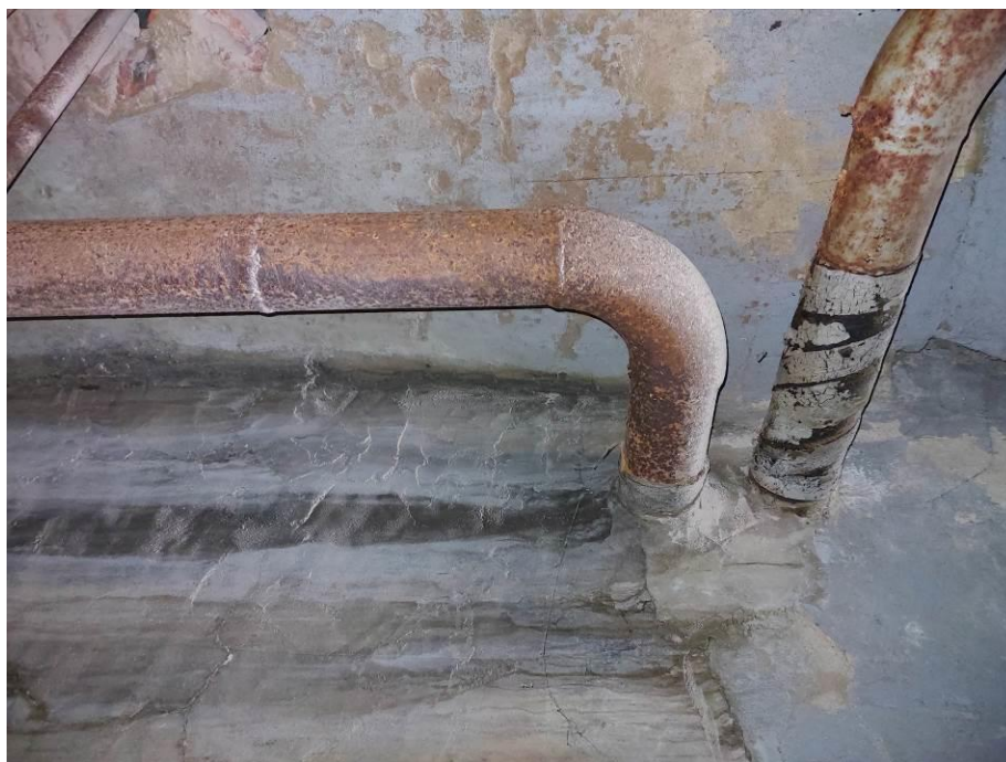
Фото 194. Пристройка к ЦИК, подвал, узел вывода ливневой и хоз-бытовой канализации.
