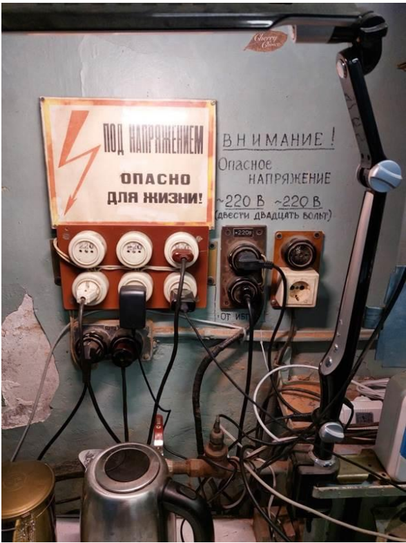
Фото 125. ЦИК, 2 этаж, система электроснабжения, выполнена с нарушением ПУЭ.
