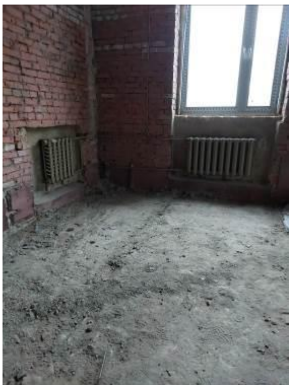
Фото 78. Пристройка ЦИК, 2 этаж, система отопления в ограниченно-работоспособном состоянии, запорно-регулирующая арматура в не работоспособном состоянии.
