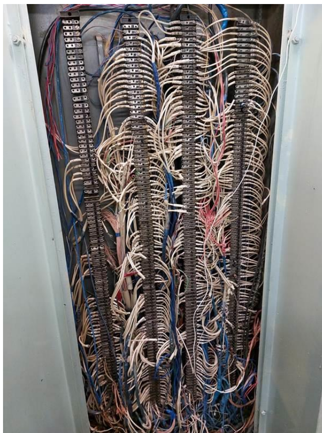
Фото 120. ЦИК, 2 этаж, коммутационный шкаф системы связи и сигнализации, отсутствуют кабельные бирки, часть кабеля не коммутирована.
