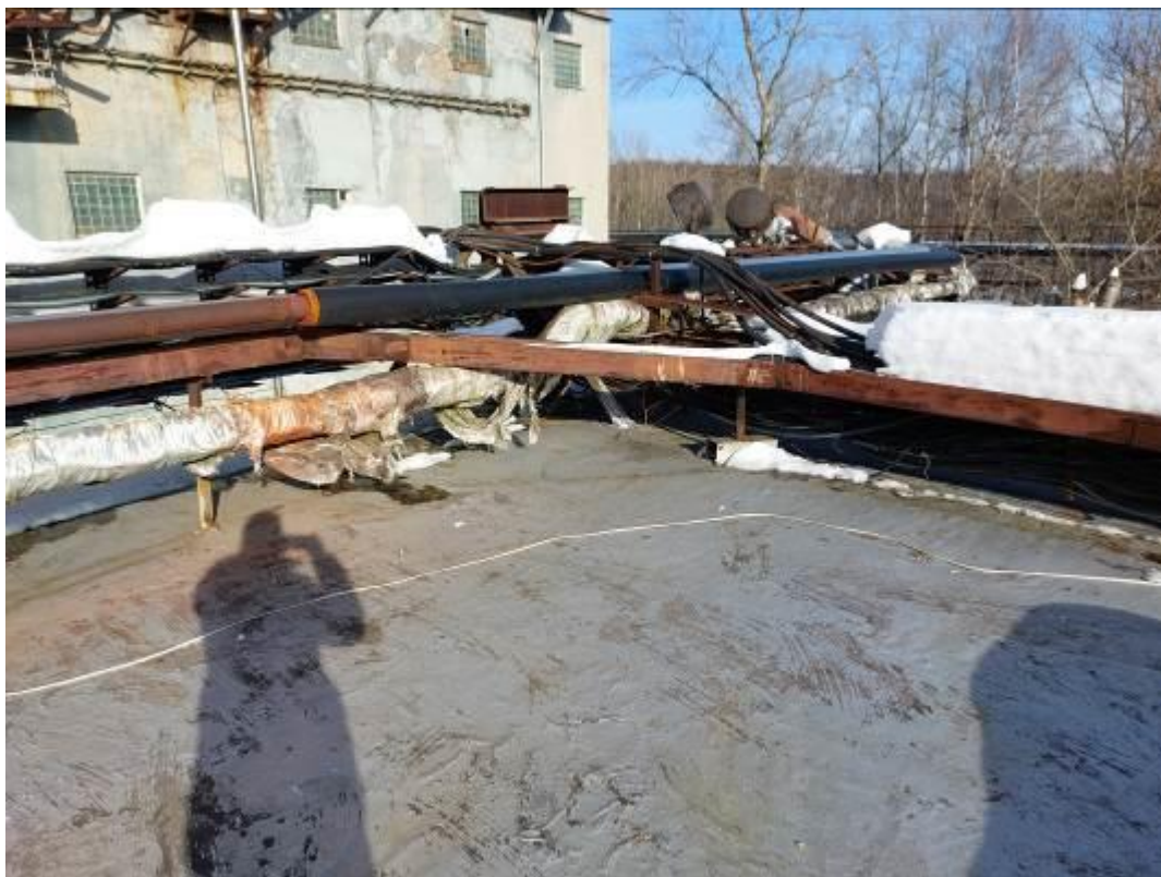
Фото 15. Кровля ЦИК, пересечение транзитных сетей и эстакад, сплошная коррозия трубопроводов и электротехнических лотков.
