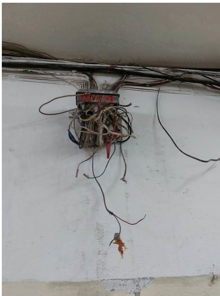
Фото 147. ЦИК, 1 этаж, соединительная коробка сетей связи, скрутки, обрезанные кабели.
