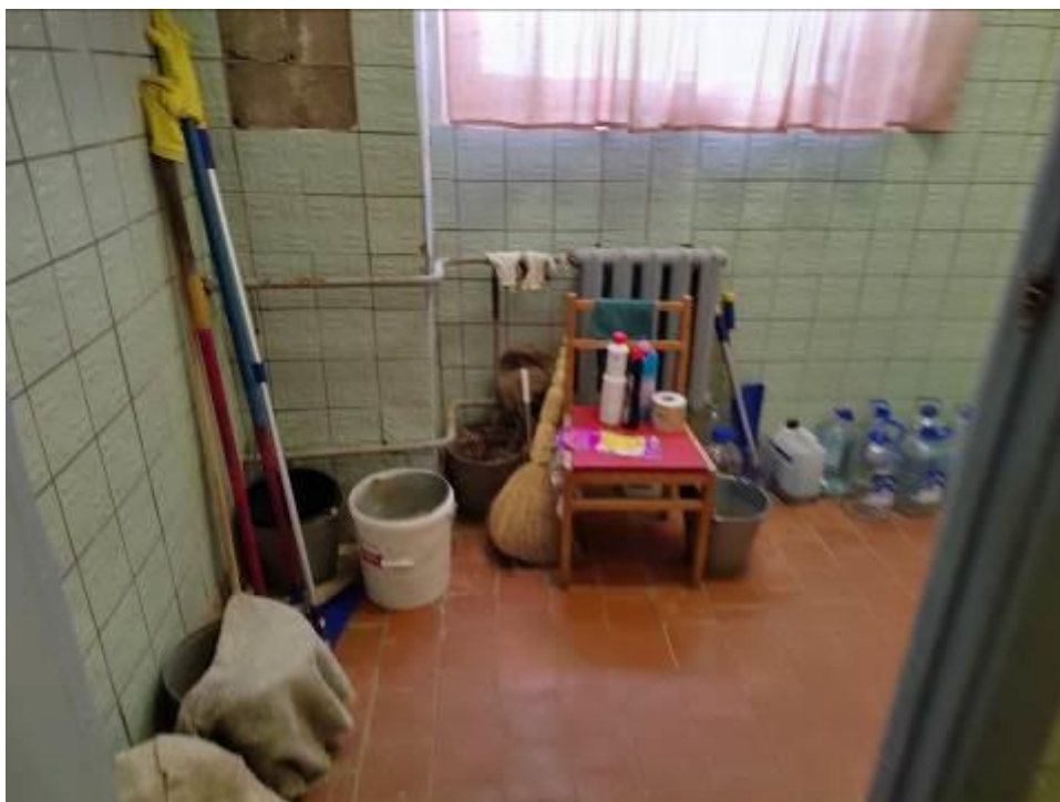
Фото 61. Пристройка ЦИК, 3 этаж, санитарный узел, система отопления в ограниченно-работоспособном состоянии, коррозия трубопроводов, запорно-регулирующая арматура в неработоспособном состоянии.
