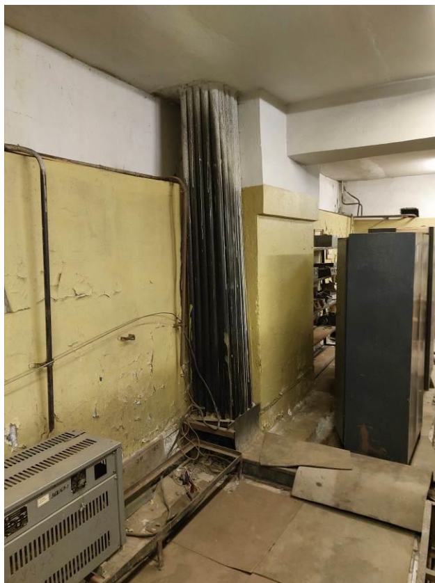
Фото 180. ЦИК, подвал, ввод кабельных линий от ТП-9, часть кабелей отключено, кабельные бирки отсутствуют.
