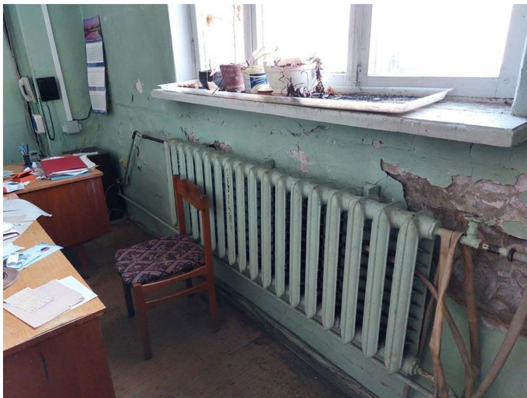
Фото 136. ЦИК, 2 этаж, коррозия трубопроводов, не рабочая запорно-регулирующая арматура.
