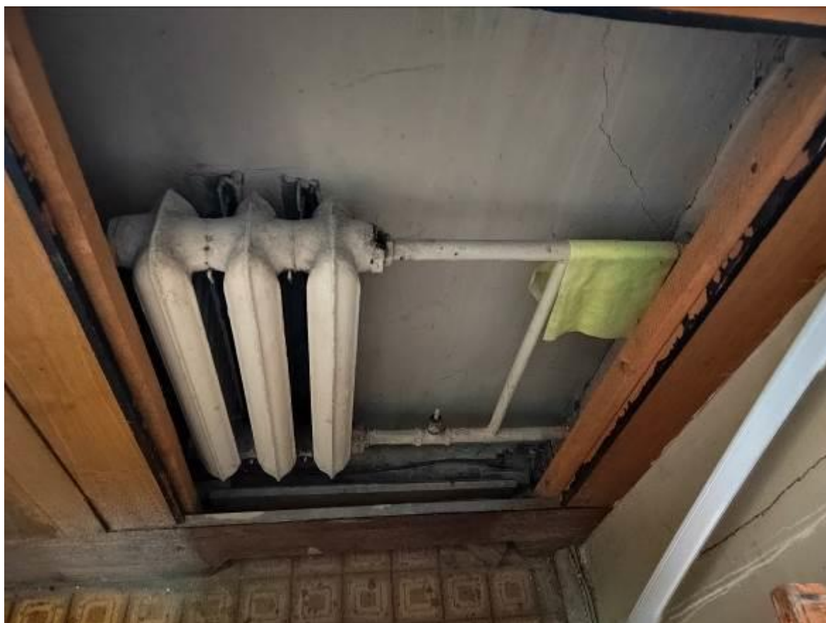
Фото 56. Пристройка ЦИК, 3 этаж, на приборах отопления выявлены следы протечек, запорно-регулирующая арматура в неработоспособном состоянии.
