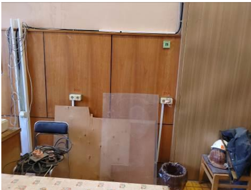
Фото 63. Пристройка ЦИК, 3 этаж, электрические проводки выполнены по временной схеме, слаботочные кабельные сети проложены совместно с силовыми сетями, часть кабельных линий не подключены.
