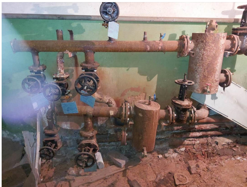
Фото 159. ЦИК, подвал, демонтированный и отключенный тепловой узел.
