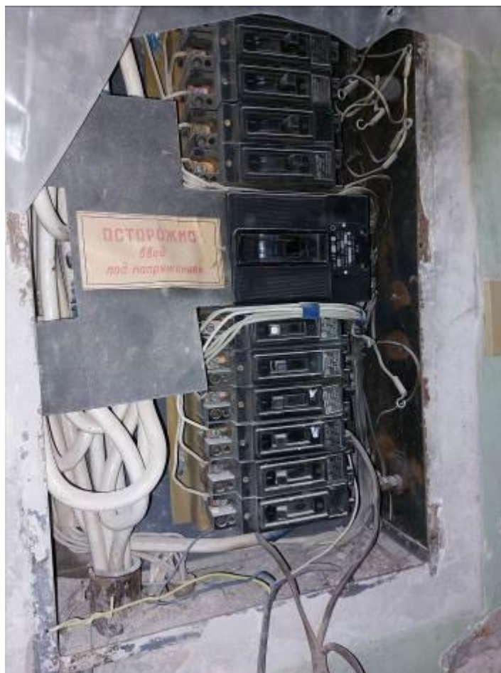
Фото 72. Пристрейка ЦИК, 2 этаж, распределительный щит освещения, отсутствуют кабельные бирки, выполнены подключения по временной схеме, отключенные кабельные линии.
