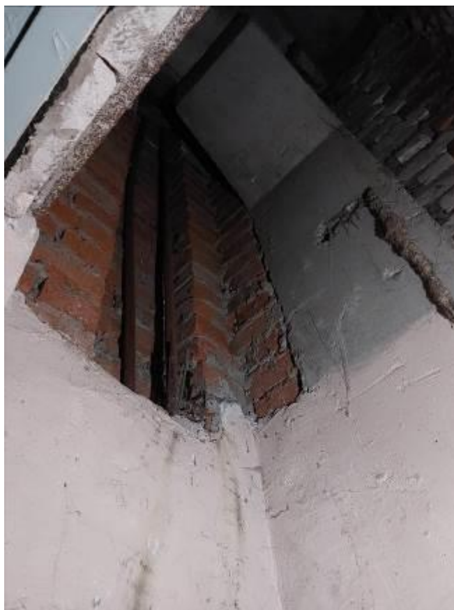
Фото 86. Пристройка ЦИК, 2 этаж, санузел, коррозия трубопроводов стояка отопления.
