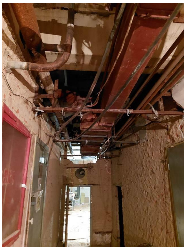
Фото 191. Пристройка к ЦИК, подвал, системы холодного водоснабжения, канализации, вентиляции сплошная коррозия трубопроводов, запорно-регулирующей арматуры, ремонтные вставки.
