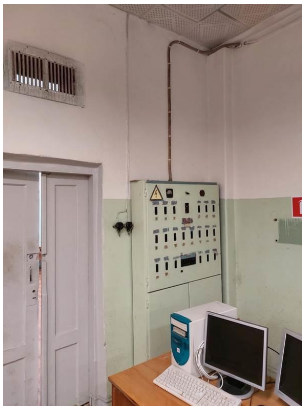
Фото 154. ЦИК, 1 этаж, щит распределительный частично не работает.
