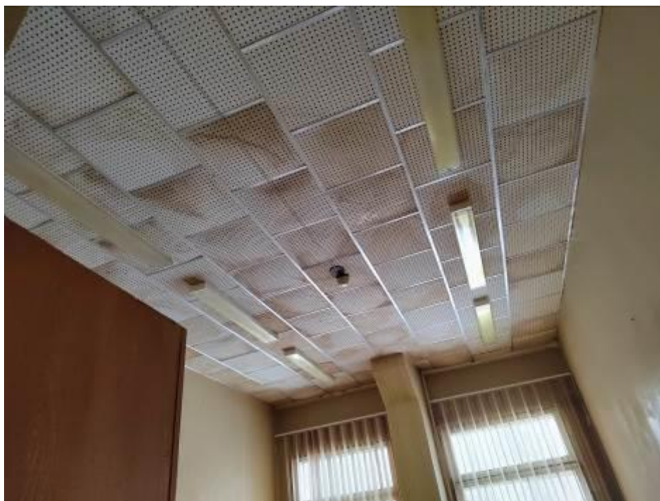
Фото 55. Пристройка ЦИК, 3 этаж, часть приборов освещения и пожарная сигнализация в неработоспособном состоянии.
