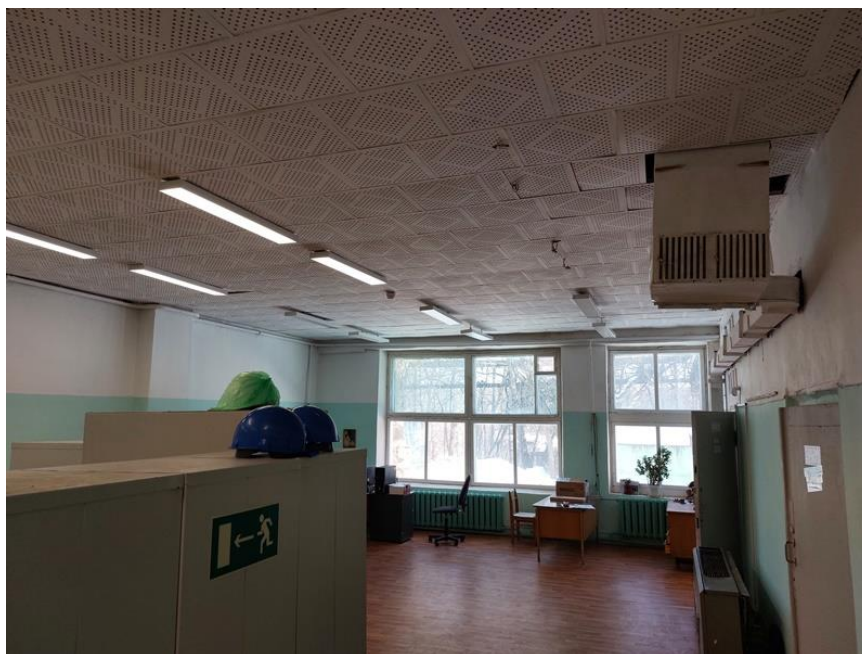
Фото 152. ЦИК, 1 этаж, местная вытяжка с рабочего места, автономный электрический отопитель, система освещения частично не работает.
