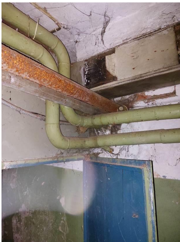
Фото 164. ЦИК, подвал, системы водоснабжения сплошная коррозия трубопроводов, система вентиляции не действующая.
