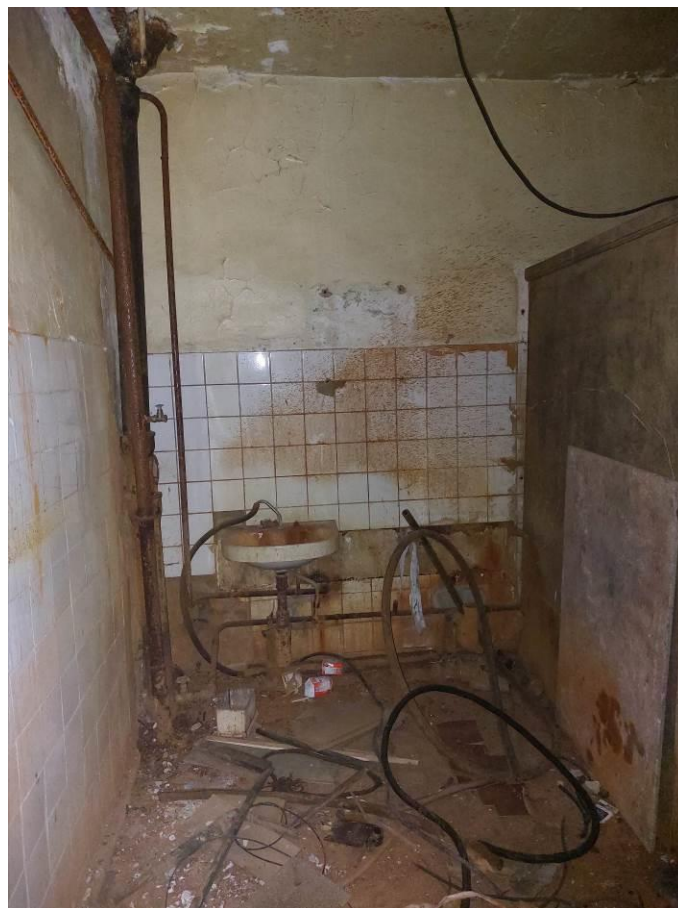
Фото 188. ЦИК, подвал, системы водоснабжения и канализации, коррозия трубопроводов, ремонтные участки, системы в не работоспособном состоянии.
