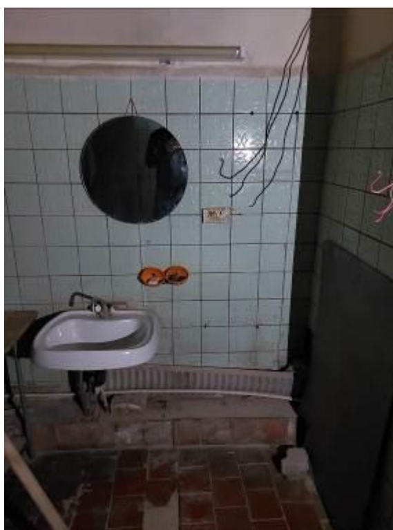
Фото 84. Пристройка ЦИК, 2 этаж, санузел в не работоспособном состоянии, трубопроводы частично срезаны, системы электроснабжения отключены, проводка осталась только внутри санузла.
