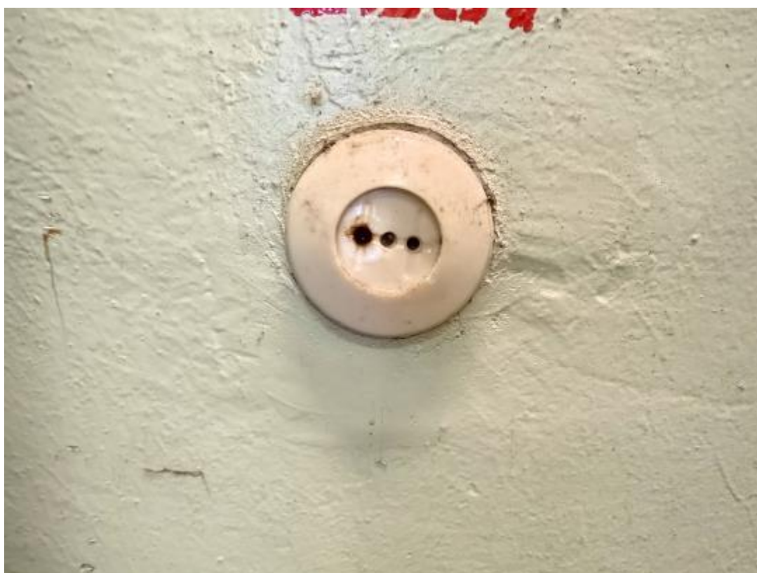
Фото 115. Пристройка ЦИК, 1 этаж, следы оплавления розеточных групп.
