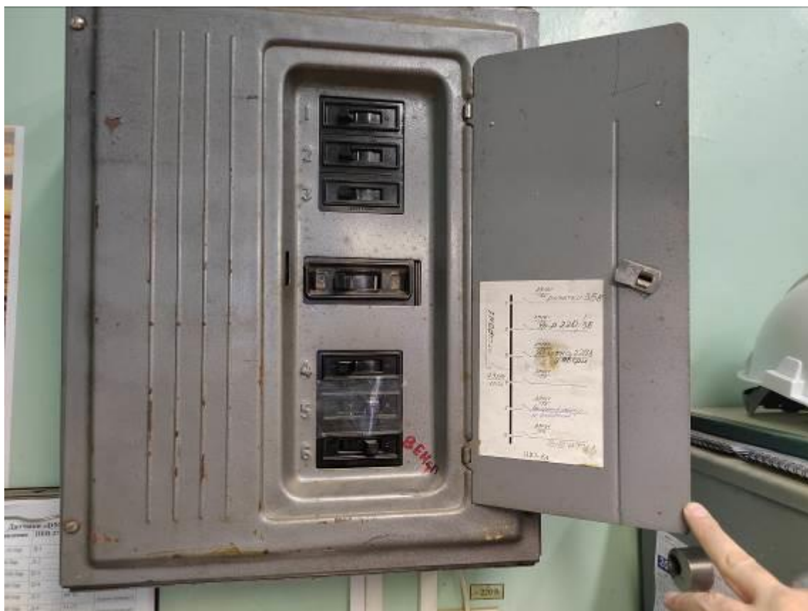
Фото 94. Пристройка ЦИК, 1 этаж, щит питания системы видеонаблюдения.
