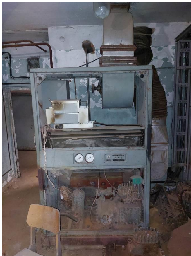
Фото 168. ЦИК, подвал, не действующая вентустановка.
