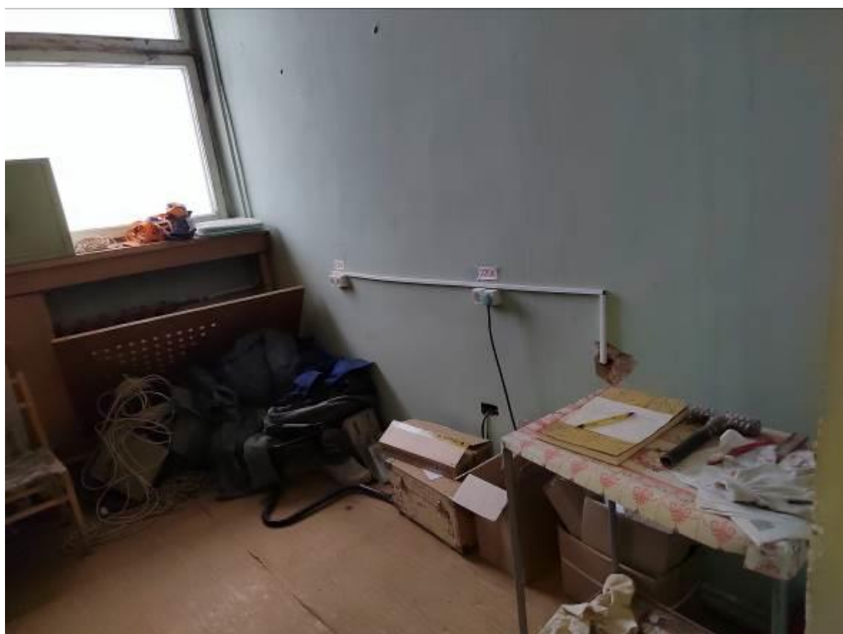
Фото 62. Пристройка ЦИК, 3 этаж, электрические проводки выполнены по временной схеме, коррозия трубопроводов системы отопления.
