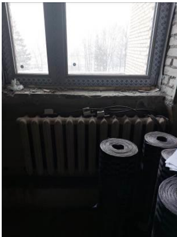
Фото 33. Пристройка ЦИК, 4 этаж, радиатор отопления отключен, подводки заглушены.
