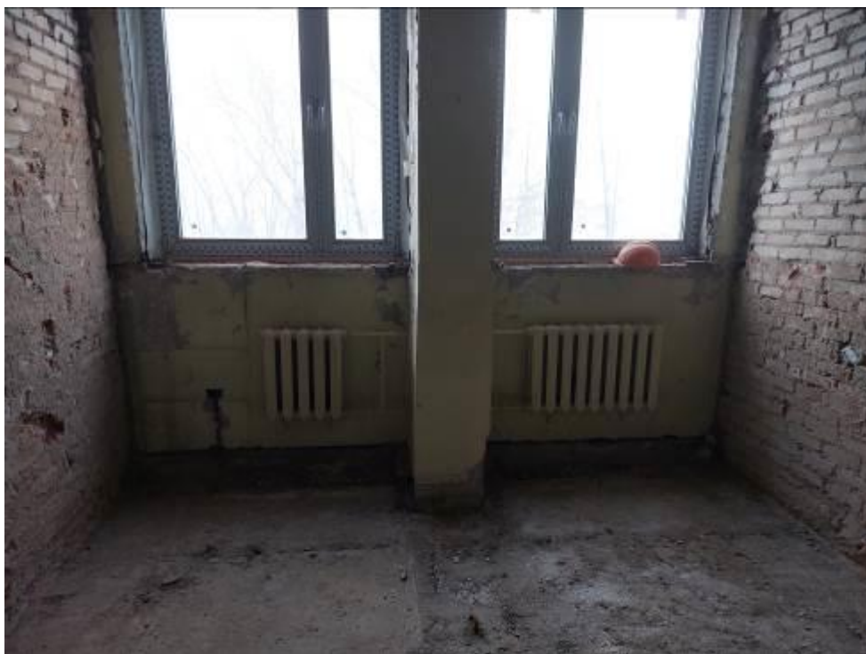
Фото 39. Пристройка ЦИК, 4 этаж, система отопления в ограниченно работоспособном состоянии.
