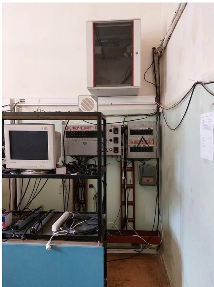
Фото 134. ЦИК, 2 этаж, щиты питания и распределения телеуправления.
