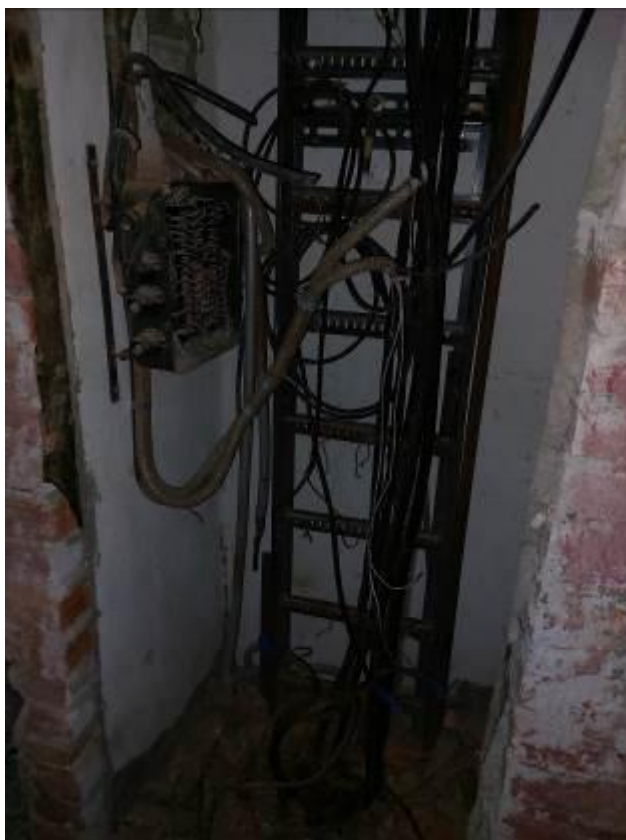
Фото 75. Пристройка ЦИК, 2 этаж, стояк систем связи и сигнализации, кабели демонтированы, отключены, проложены силовые кабели.
