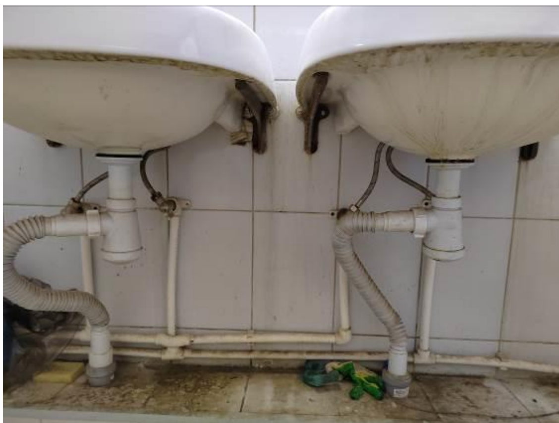
Фото 100. Пристройка ЦИК, 1 этаж, трубопроводы системы водоснабжения частично заменены на полипропиленовые.
