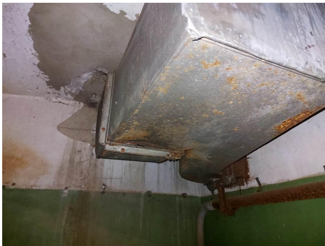
Фото 161. ЦИК, подвал, сплошная коррозия, трубопроводов, не действующая вентиляция.
