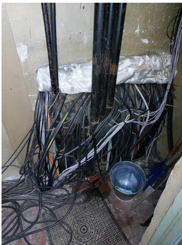
Фото 119. ЦИК, 2 этаж, вывод кабелей систем связи, сигнализации и электроснабжения на кровлю, на эстакады, отсутствуют кабельные бирки, часть кабеля обрезана.
