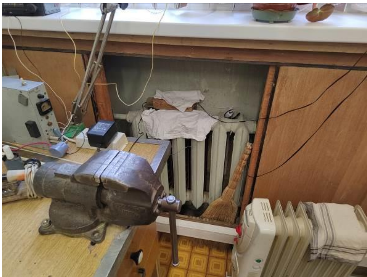
Фото 68. Пристройка ЦИК, 3 этаж, установлен масляный радиатор, система отопления в ограниченно-работоспособном состоянии.
