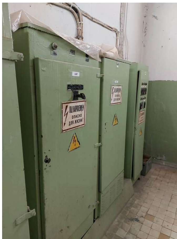
Фото 149. ЦИК, 1 этаж, щит АВР, щит распределительный и щит управления.
