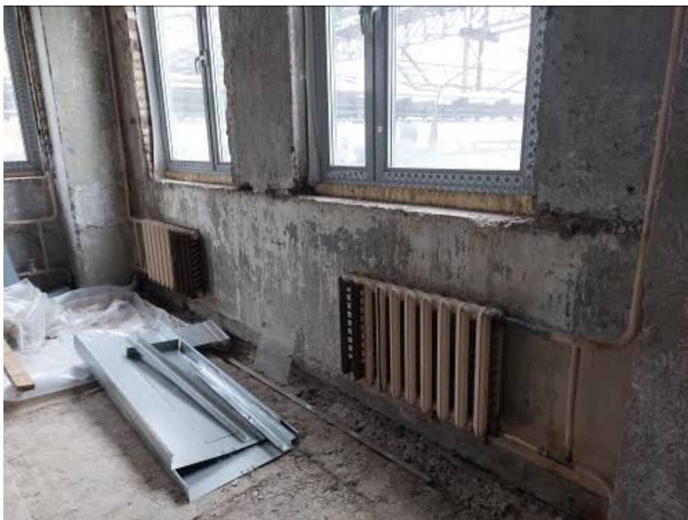
Фото 73. Пристройка ЦИК, 2 этаж, система отопления в ограниченно-работоспособном состоянии, следы протечек, ремонтов, коррозия трубопроводов, отсутствует или находится в неработоспособном состоянии запорно-регулирующая арматура.
