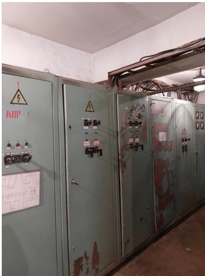
Фото 186. ЦИК, подвал, щиты АВР и распределительные, отсутствуют кабельные бирки, частично разукomплектованы, частично не работают, частично отключены.
