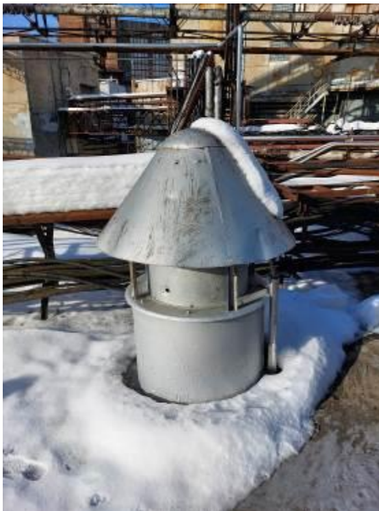
Фото 19. Кровля ЦИК, крышный вентилятор местной вытяжки.
