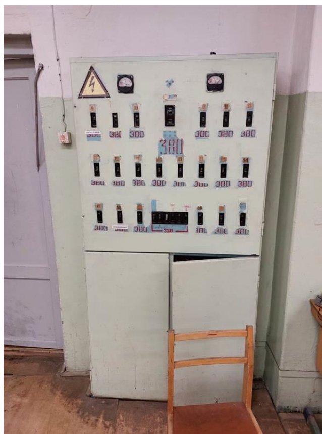
Фото 153. ЦИК, 1 этаж, щит распределительный частично не работает.
