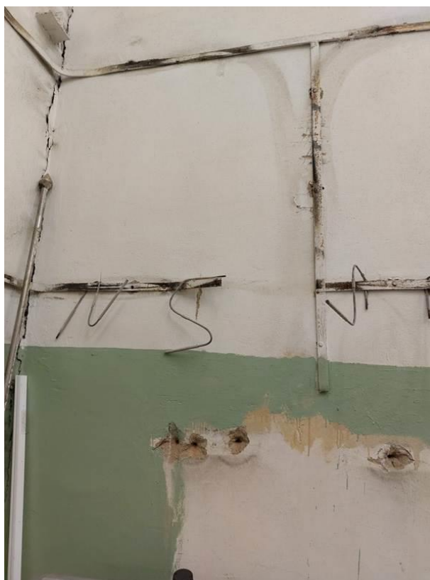
Фото 139. ЦИК, 2 этаж, демонтированный контур заземления.
