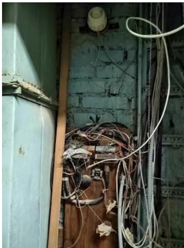
Фото 59. Пристройка ЦИК, 3 этаж, стояк сетей сигнализации и связи, отсутствуют кабельные бирки, часть проводов срезана, сети сигнализации и связи в неработоспособном состоянии.
