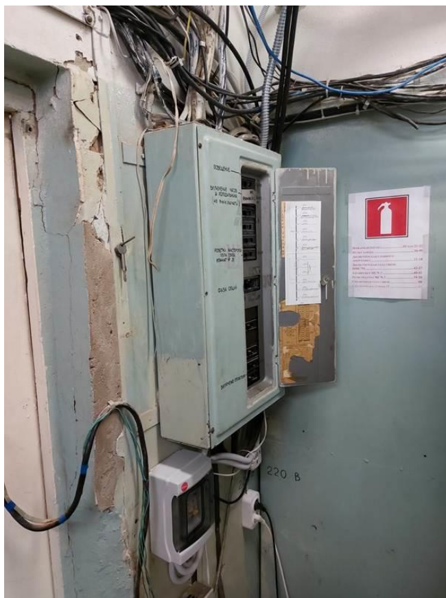
Фото 132. ЦИК, 2 этаж, кабельные трассы уложены с нарушением ПУЭ, отсутствуют кабельные бирки, имеются поврежденные и обесточенные кабели, от старого щита запитан новый щиток.
