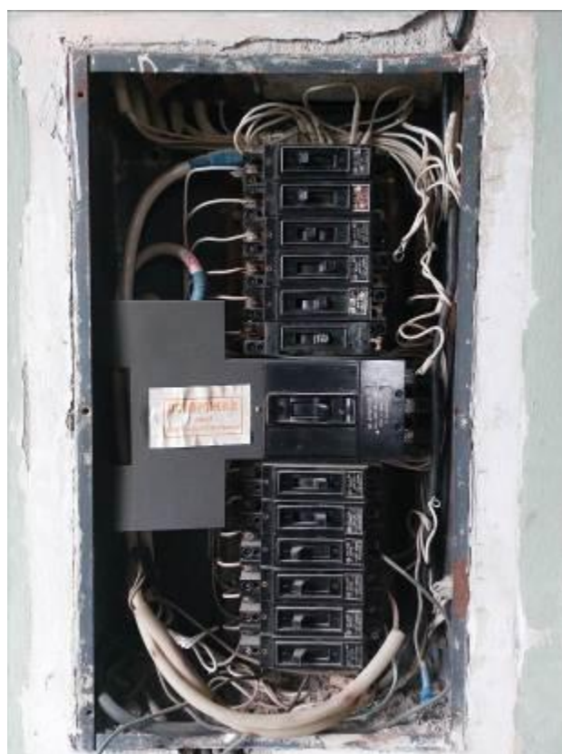
Фото 32. Пристройка ЦИК, 4 этаж, распределительный щит, отсутствует схема щита, отсутствуют кабельные бирки и маркировки, часть кабелей не подключена, часть кабелей подключена по временной схеме.
