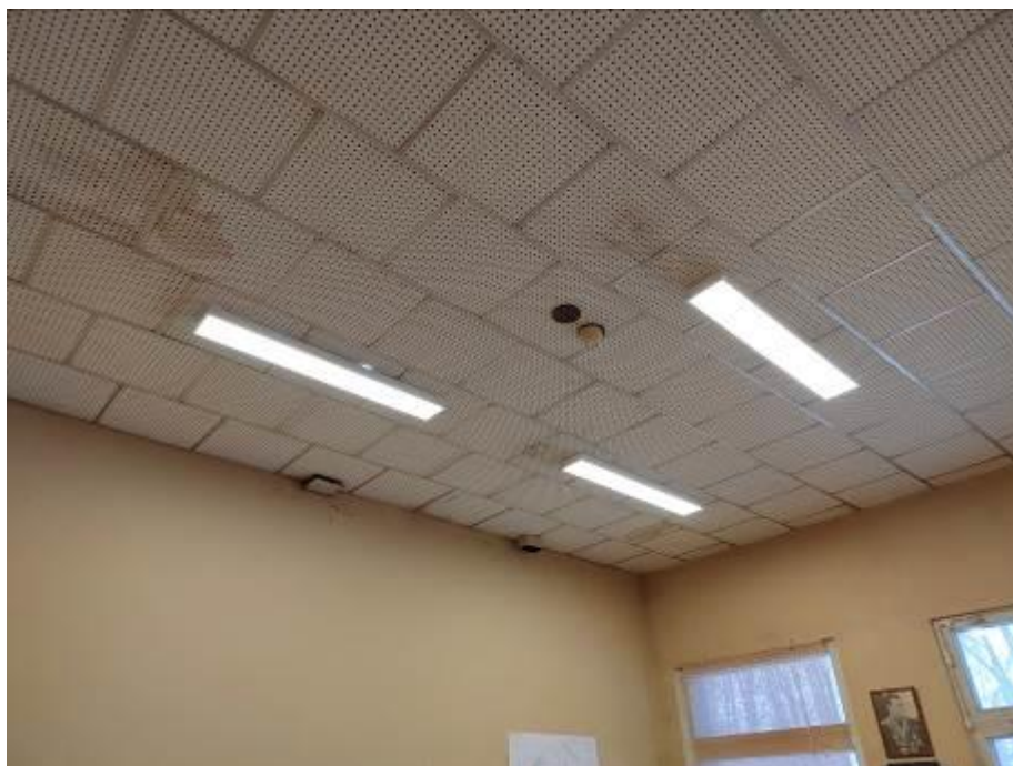
Фото 95. Пристройка ЦИК, 1 этаж, система вентиляции в не работоспособном состоянии, система пожарной сигнализации в неработоспособном состоянии.
