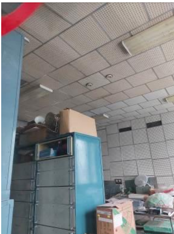
Фото 45. Пристройка ЦИК, 4 этаж, система пожарной сигнализации в неработоспособном состоянии, система электроснабжения в ограниченно-работоспособном состоянии часть светильников не работает, часть розеточных групп не работает, имеются следы оплавления проводки.
