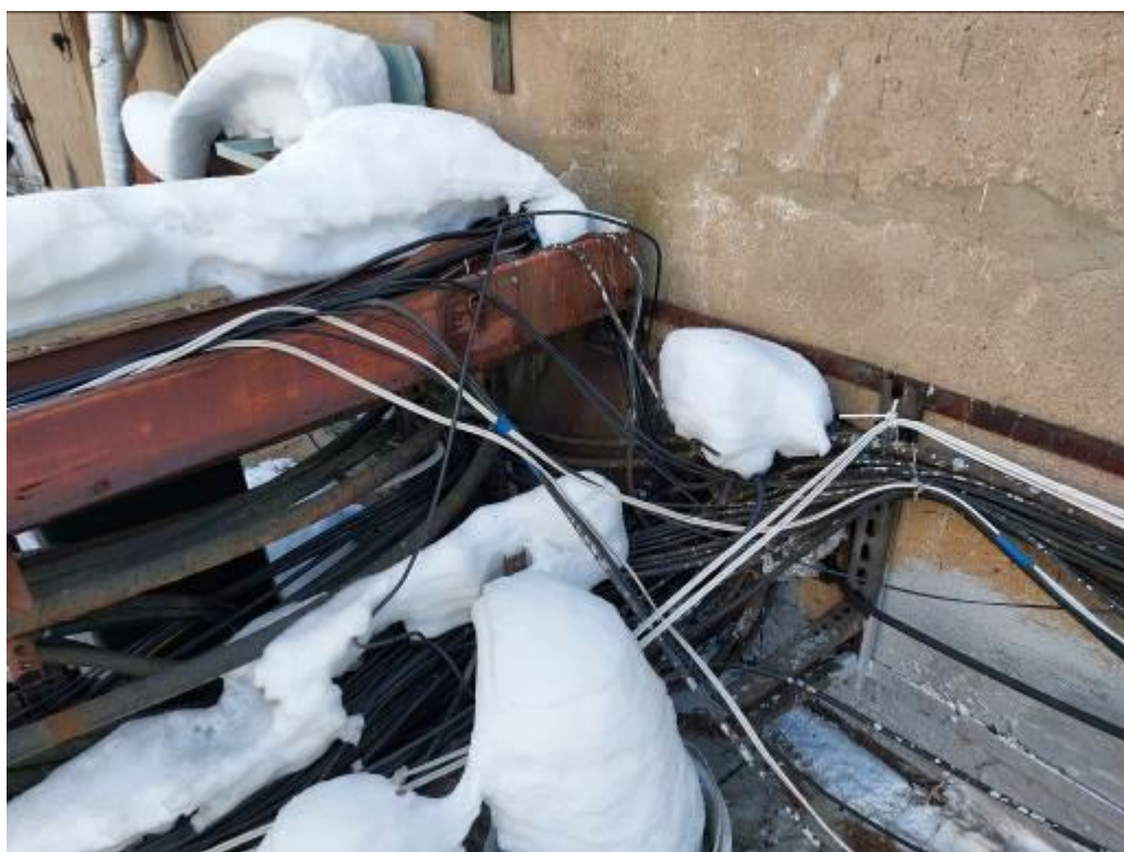
Фото 16. Кровля ЦИК, вывод сетей связи и сигнализации, отсутствие кабельных бирок, сплошная коррозия электротехнических лотков, провисы и натяжение кабелей снежными наносами.
