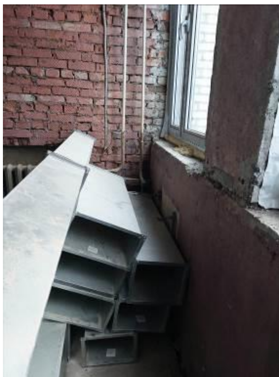
Фото 80. Пристройка ЦИК, 2 этаж, система отопления в ограниченно-работоспособном состоянии, радиатор демонтирован, подводы заглушены.
