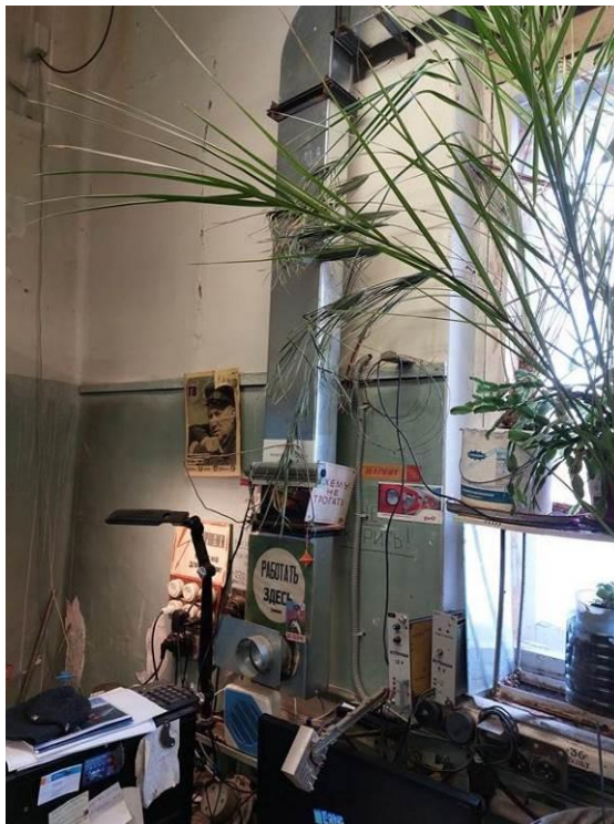
Фото 122. ЦИК, 2 этаж, местная вытяжная вентиляция в узле связи.
