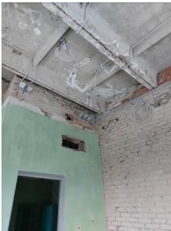
Фото 41. Пристройка ЦИК, 4 этаж, системы вентиляции и электроснабжения демонтированы, смонтированные сети электроснабжения не расключены.
