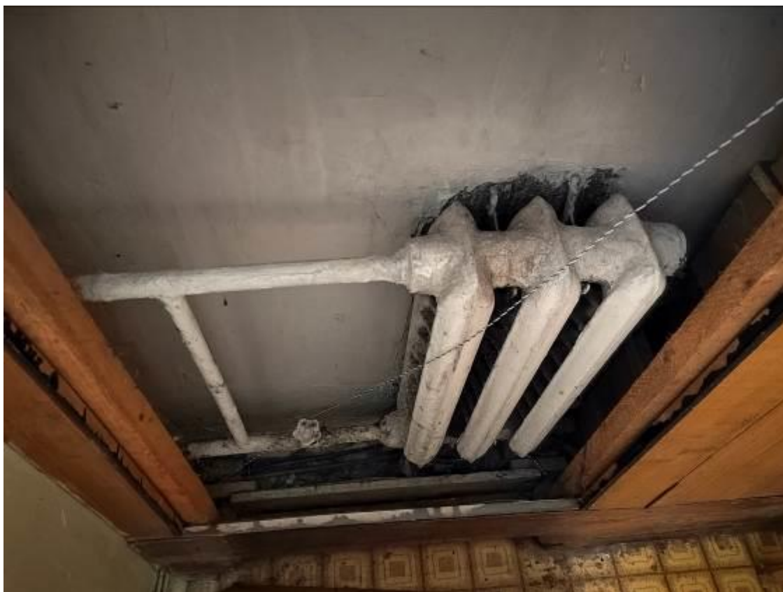
Фото 57. Пристройка ЦИК, 3 этаж, на приборах отопления выявлены следы протечек, запорно-регулирующая арматура в неработоспособном состоянии.
