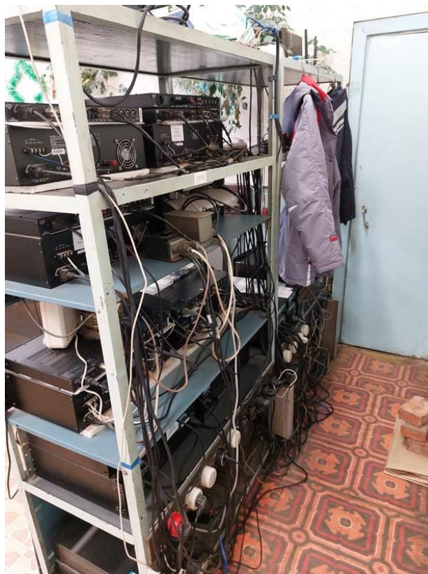
Фото 127. ЦИК, 2 этаж, стойка системы сигнализации и оповещения.
