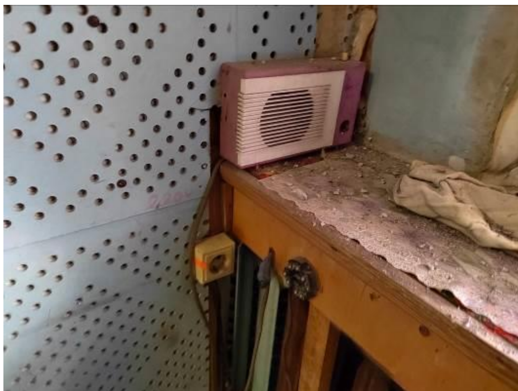
Фото 106. Пристройка ЦИК, 1 этаж, силовая розетка со следами оплавления, система связи и сигнализации, ограниченно работоспособна.
