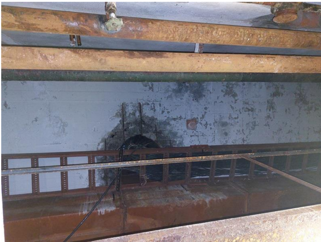
Фото 148. ЦИК, 1 этаж, сплошная коррозия трубопроводов.
