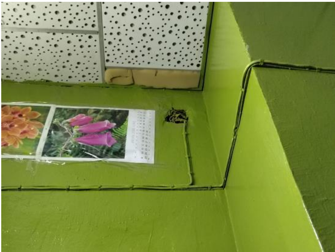
Фото 109. Пристройка ЦИК, 1 этаж, отсутствует распаячная коробка, соединения выполнены на скрутках, в нарушении ПУЭ.
