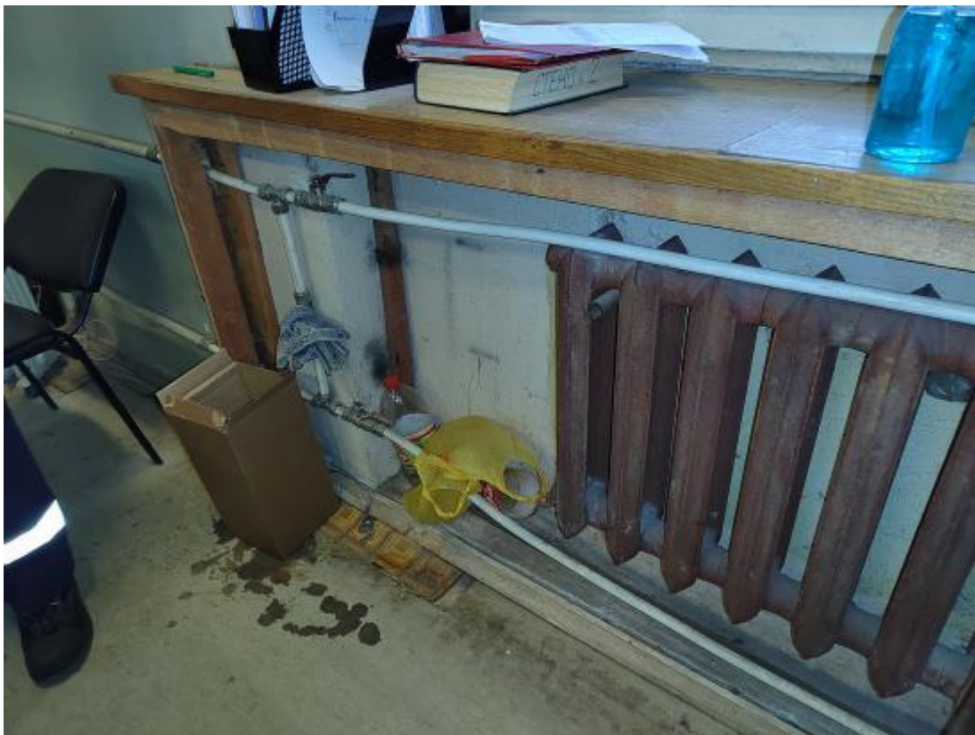
Фото 111. Пристройка ЦИК, 1 этаж, система отопления в не работоспособном состоянии, байпас выполнен из металлопластиковой трубы.
