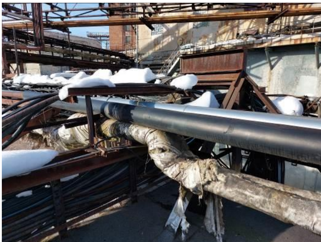
Фото 14. Кровля ЦИК, пересечение транзитных эстакад, тепловые трубопроводы уложены над электрическими кабельными линиями.
