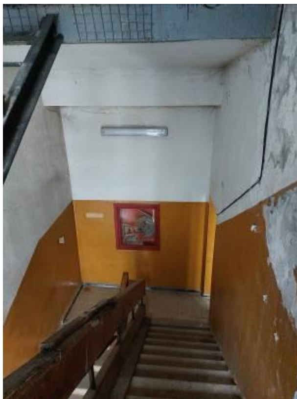
Фото 31. Пристройка ЦИК, лестничная клетка, пожарный гидрант – отключен, светильник не работает.
