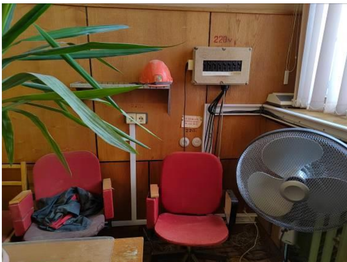
Фото 64. Пристройка ЦИК, 3 этаж, электрические проводки выполнены по временной схеме, слаботочные кабельные сети проложены совместно с силовыми сетями, часть кабельных линий не подключены, отсутствуют кабельные бирки, маркировка кабеля отсутствует.
