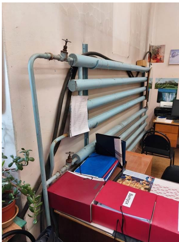
Фото 138. ЦИК, 2 этаж, дополнительный регистр отопления.
