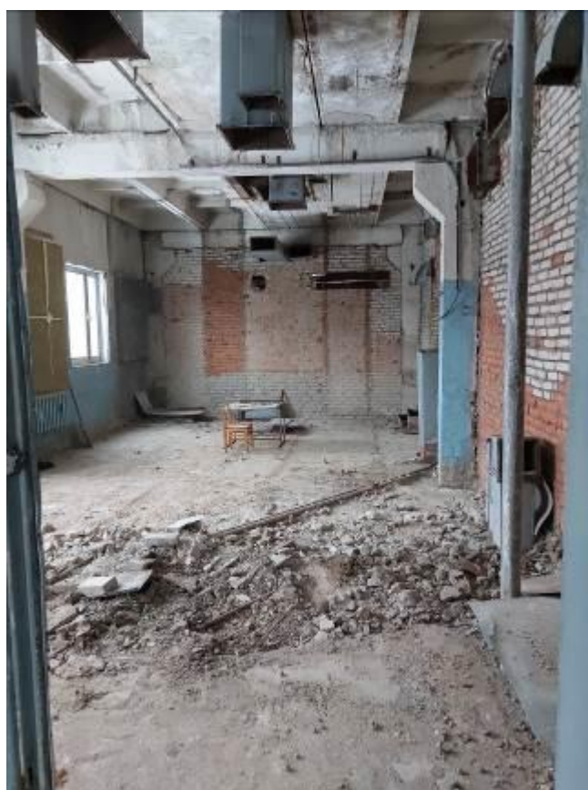
Фото 50. Пристройка ЦИК, 4 этаж, вент камера, оборудование демонтировано, вентканалы демонтированы, системы электроснабжения отсутствуют, системы отопления в ограниченно-работоспособном состоянии, коррозия трубопроводов, отсутствует или не исправна запорно-регулирующая арматура.
