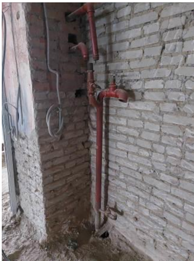
Фото 83. Пристройка ЦИК, 2 этаж, система пожаротушения в не работоспособном состоянии, трубопроводы срезаны, шкаф разукomплектован.
