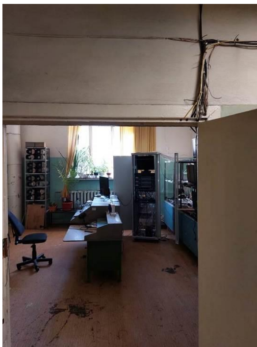
Фото 133. ЦИК, 2 этаж, помещение телевизионного наблюдения, ввод кабеля в помещение выполнен с нарушением ПУЭ.
