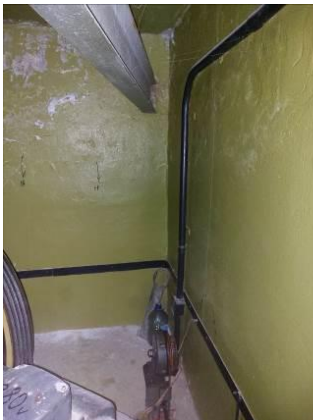
Фото 28. Пристройка ЦИК, помещение лифтового оборудования, контур заземления.
