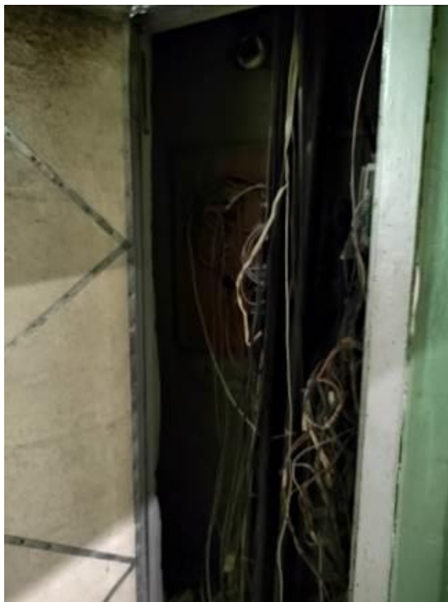
Фото 98. Пристройка ЦИК, 1 этаж, стояк систем связи и сигнализации и силовых кабелей, маркировки отсутствуют, кабельные бирки отсутствуют, стояк частично разукomплектован.
