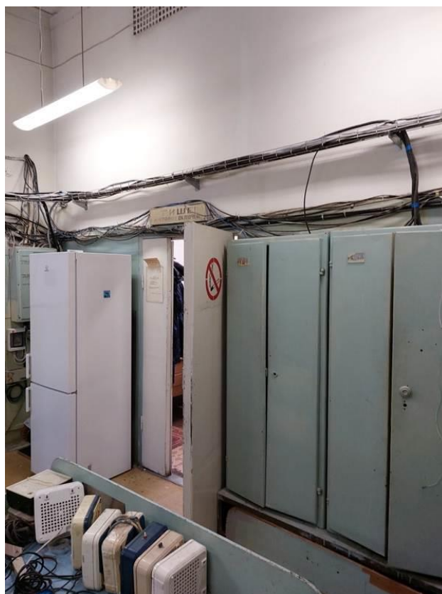
Фото 121. ЦИК, 2 этаж, прокладка кабельных трасс в узле связи.
