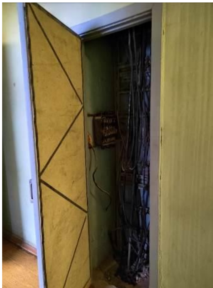
Фото 66. Пристройка ЦИК, 3 этаж, стояк системы электроснабжения, часть кабелей демонтирована, часть кабелей не расключена, отсутствуют кабельные бирки.
