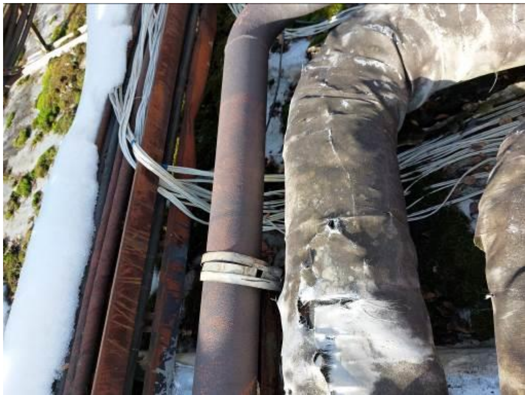
Фото 18. Кровля ЦИК, прокладка сетей связи и сигнализации вне лотков, кабель уложен на трубы тепло и пароснабжения.
