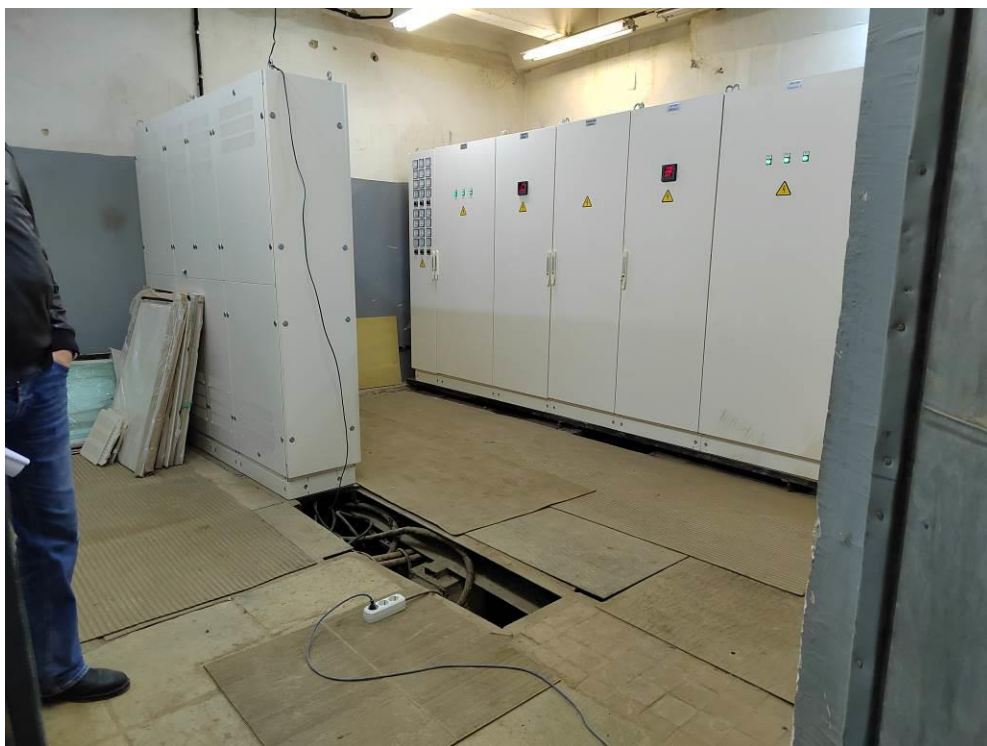
Фото 196. Пристройка к ЦИК, подвал, электрощитовая, подводящие и отходящие кабели старые (1970 – 75 годов выпуска), оборудование задействовано частично.
