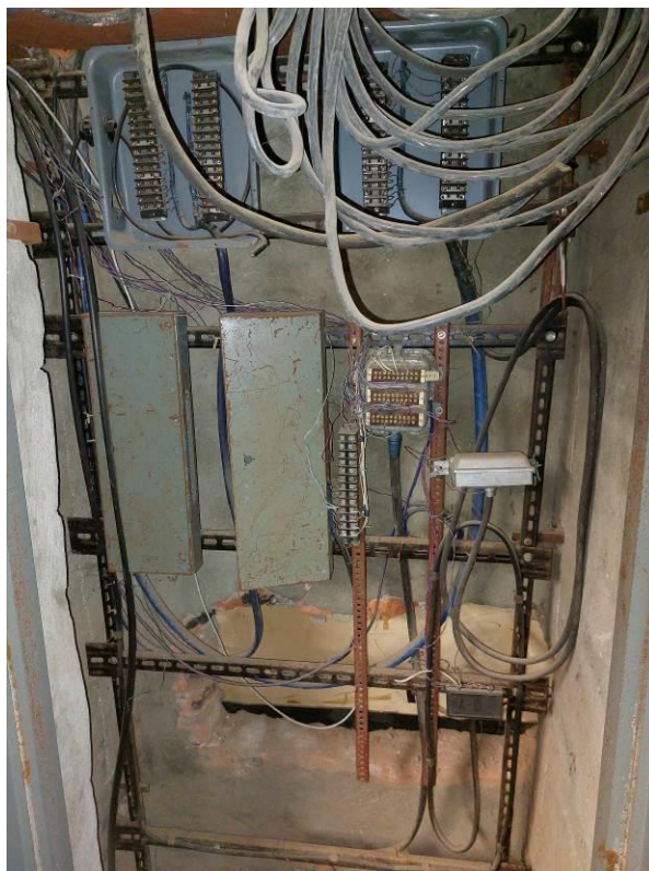
Фото 174. ЦИК, подвал, щиты связи частично разукomплектованы.
