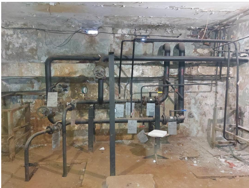
Фото 166. ЦИК, подвал, ввод теплосети, тепловой узел.
