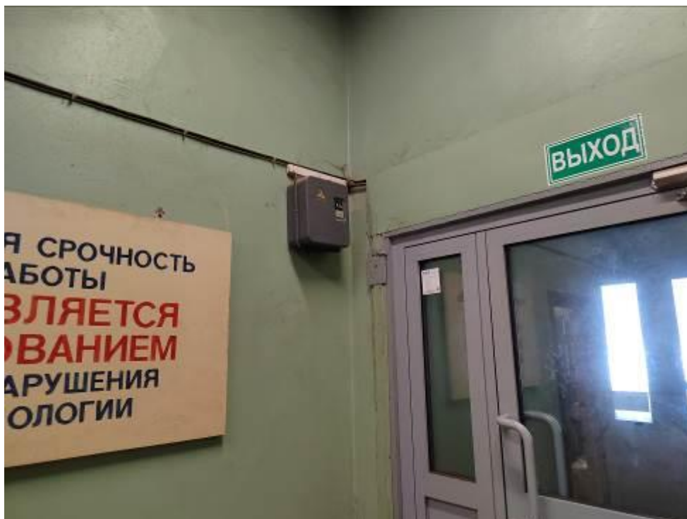
Фото 89. Пристройка ЦИК, 1 этаж, распределительный щит, маркировка отсутствует.
