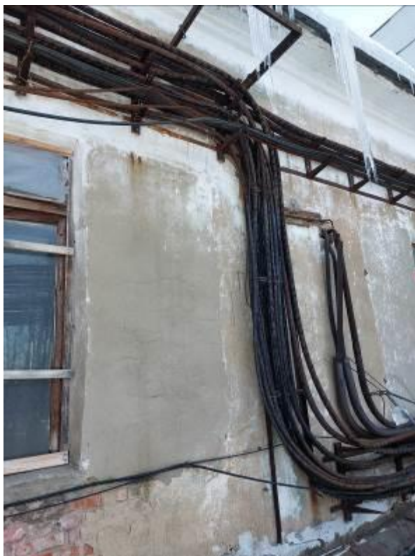
Фото 22. Кровля ЦИК, сети электроснабжения, сети связи и сигнализации, сплошная коррозия и местные повреждения изоляции кабельной продукции.
