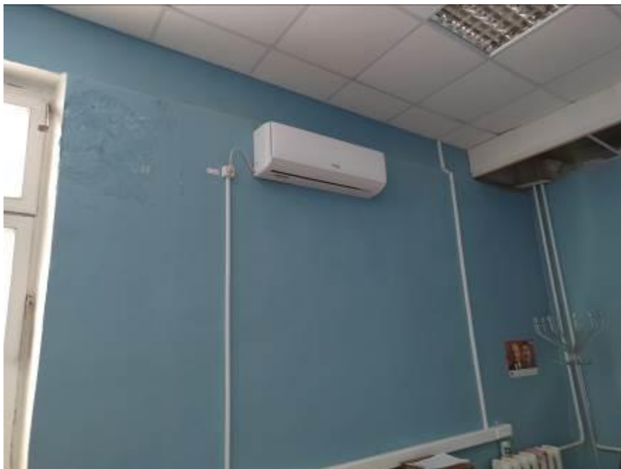
Фото 65. Пристройка ЦИК, 3 этаж, выполнено местное кондиционирование, в запотолочном пространстве коррозия трубопроводов системы отопления.
