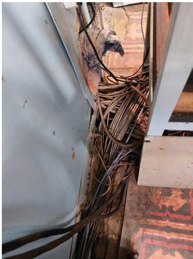
Фото 131. ЦИК, 2 этаж, кабельные трассы уложены с нарушением ПУЭ, имеются поврежденные и обесточенные кабели.
