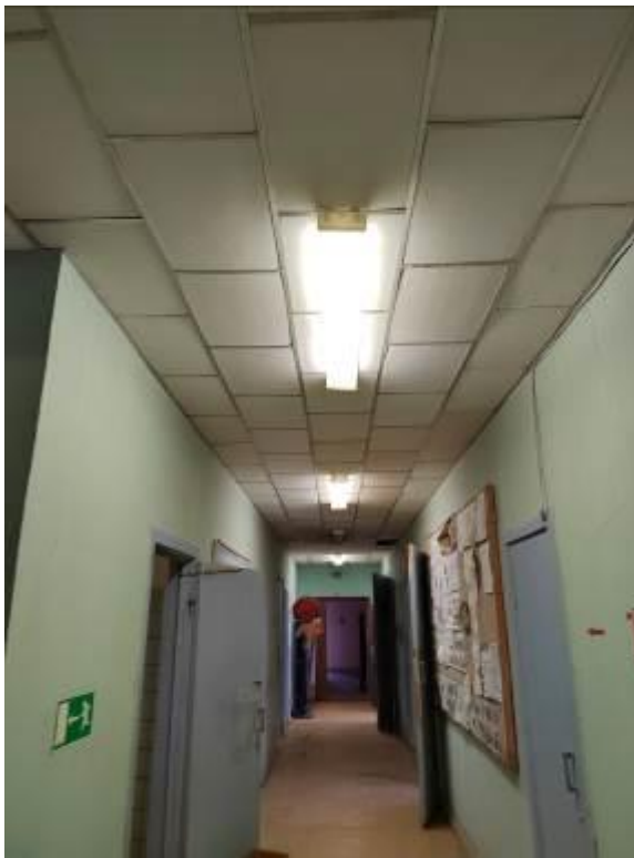
Фото 53. Пристройка ЦИК, 3 этаж, часть приборов освещения не работает.
