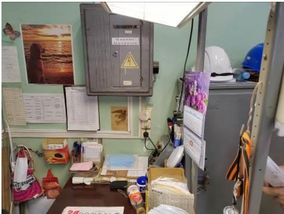
Фото 93. Пристройка ЦИК, 1 этаж, щит питания системы видеонаблюдения, от него кустарно запитаны розетки силовые, выполнена проводка.
