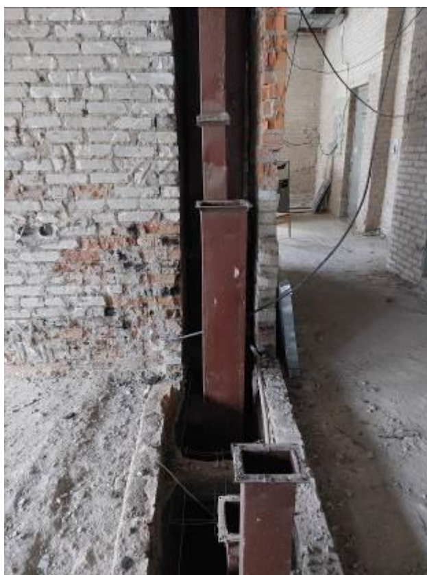
Фото 74. Пристройка ЦИК, 2 этаж, система вентиляции в не работоспособном состоянии, воздуховоды демонтированы.
