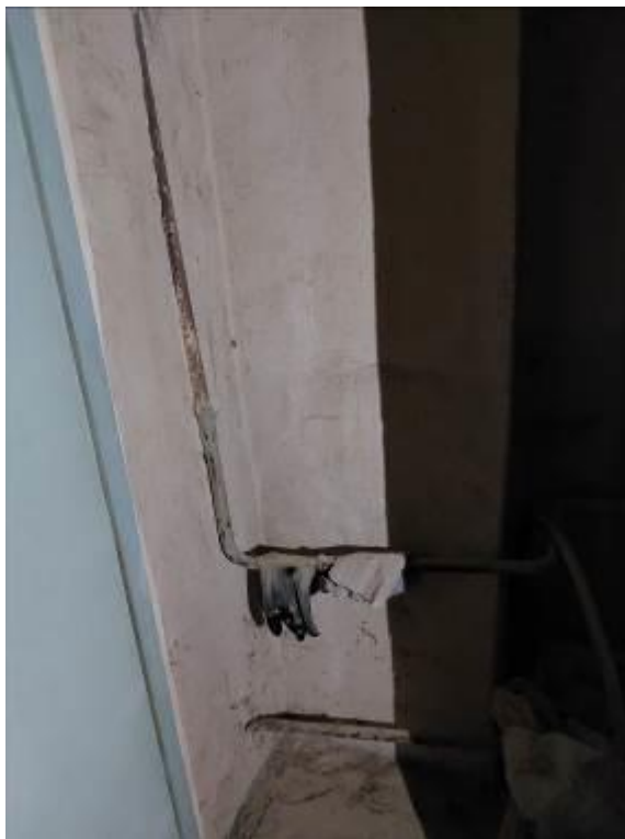
Фото 85. Пристройка ЦИК, 2 этаж, санузел, коррозия трубопроводов отопления.
