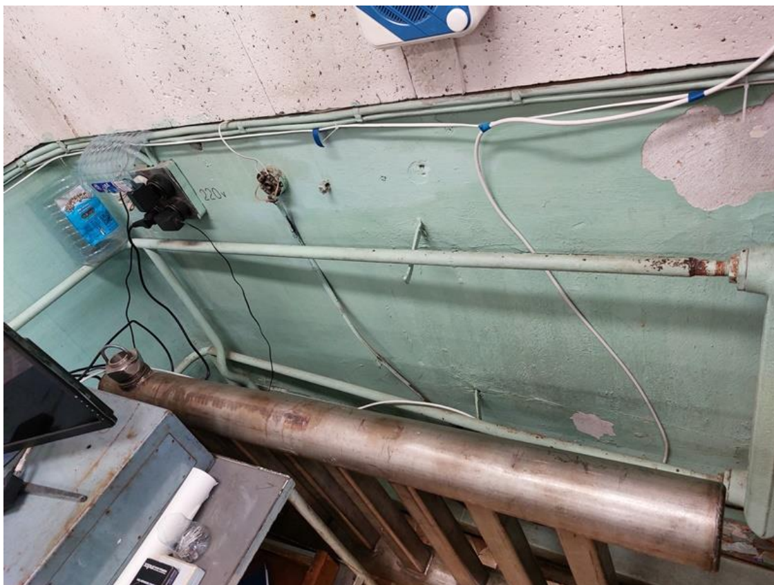
Фото 128. ЦИК, 2 этаж, система отопления в не работоспособном состоянии, установлен кустарно собранный масляный обогреватель.
