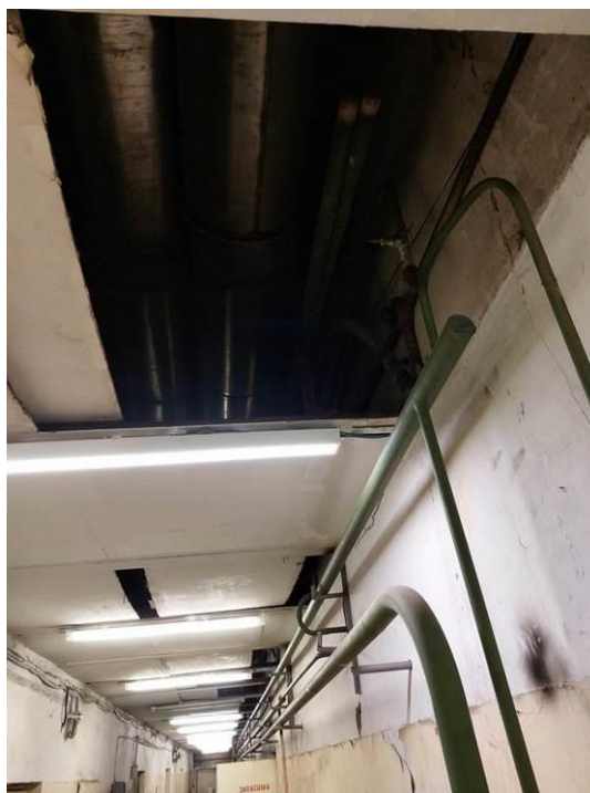
Фото 146. ЦИК, 1 этаж, срезанные трубопроводы, трубопроводы продукта транзитные.
