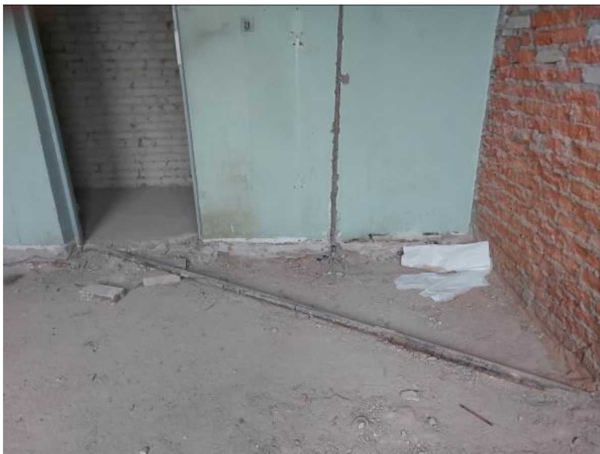
Фото 42. Пристройка ЦИК, 4 этаж, системы вентиляции и электроснабжения демонтированы, закладные под электрические сети частично демонтированы.
