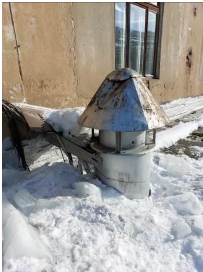
Фото 20. Кровля ЦИК, крышный вентилятор местной вытяжки, повреждение кожуха.
