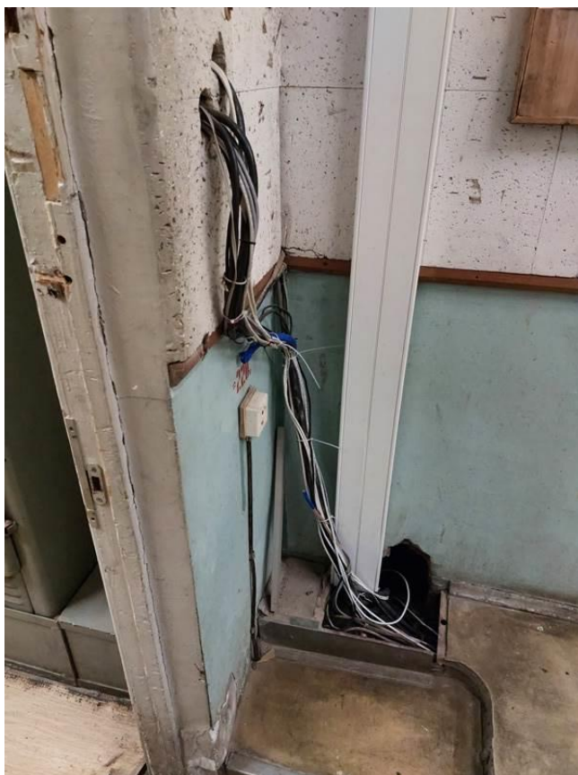
Фото 144. ЦИК, 2 этаж, прокладка кабеля не соответствует ПУЭ.
