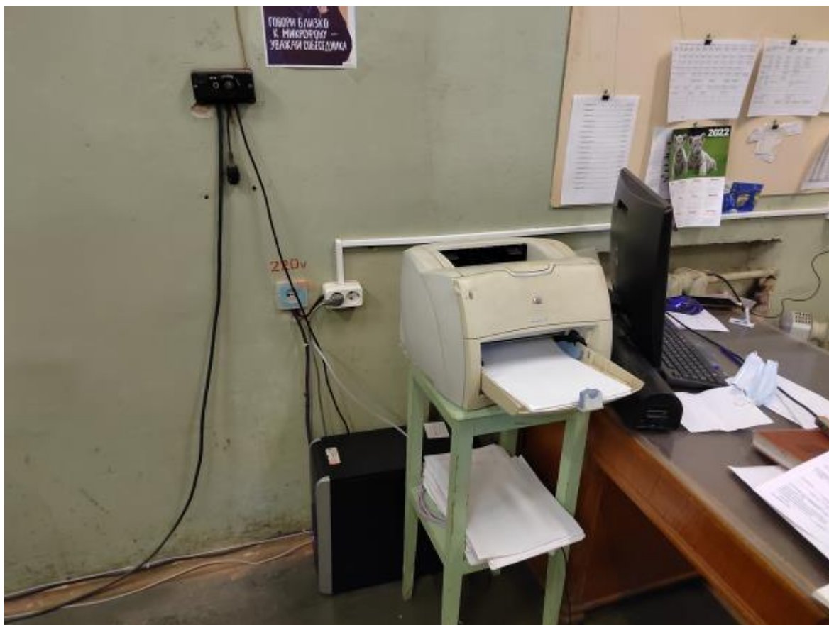
Фото 112. Пристройка ЦИК, 1 этаж, электропитание новых розеточных групп осуществляется от розеточной сети 220В, кустарным способом в нарушении ПУЭ.
