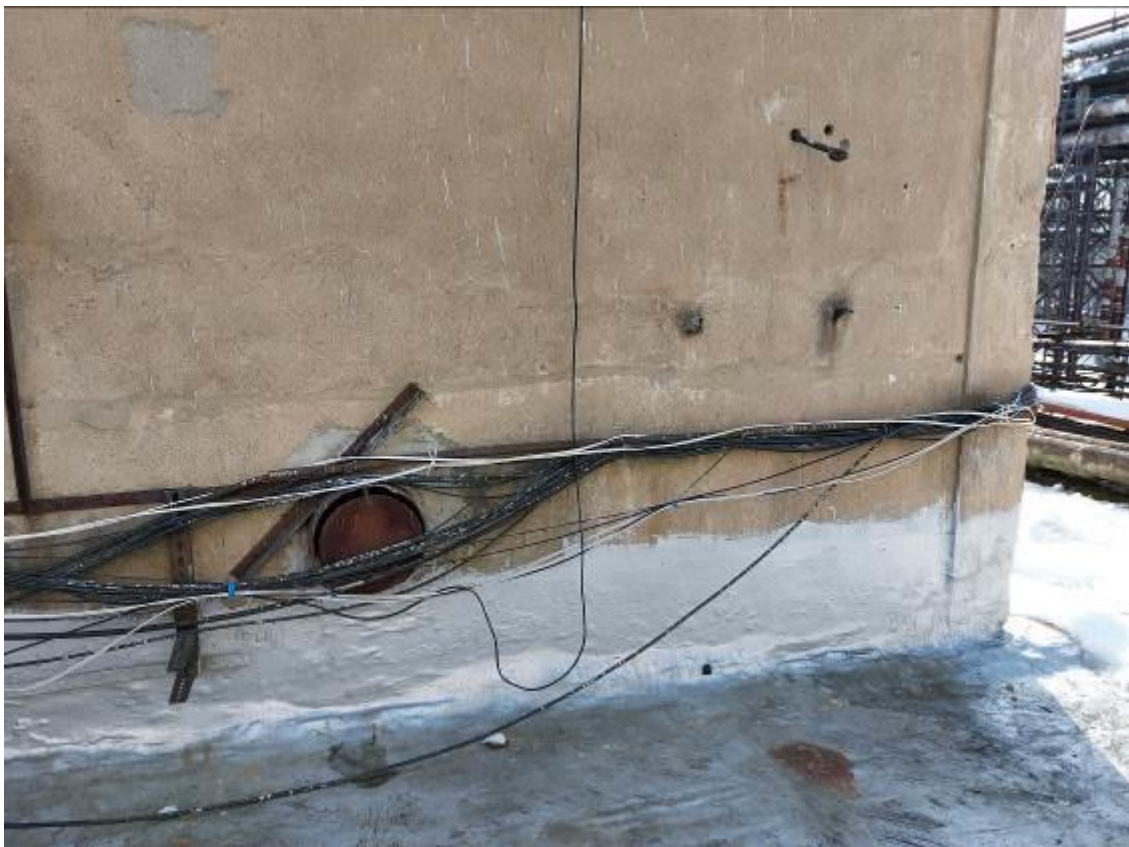
Фото 17. Кровля ЦИК, прокладка сетей связи и сигнализации вне лотков, провисы отсутствие опор.
