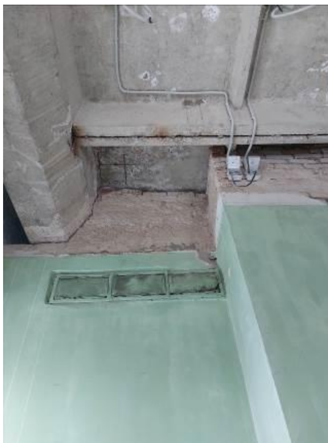
Фото 38. Пристройка ЦИК, 4 этаж, система вентиляции в не работоспособном состоянии, отключена, системы электроснабжения не подключены.
