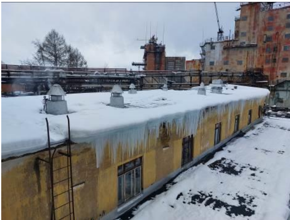
Фото 9. Кровля ЦИК, местные кровельные вытяжные вентиляторы из конкретных помещений.
