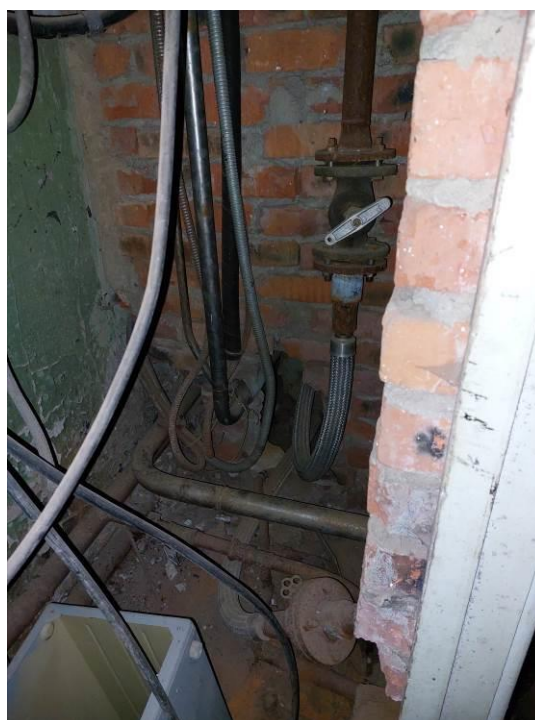
Фото 187. ЦИК, подвал, системы водоснабжения и теплоснабжения, коррозия трубопроводов, ремонтные участки, подключения по временной схеме.
