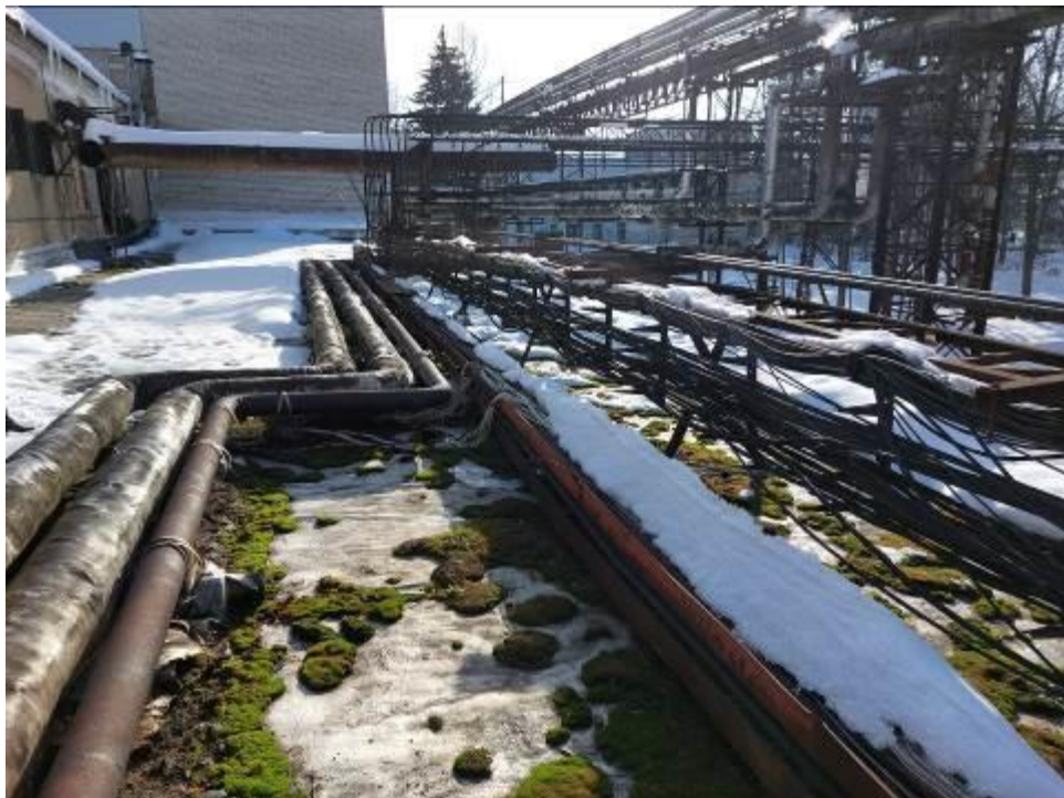
Фото 21. Кровля ЦИК, прокладка сетей теплоснабжения, пароснабжения, электрических и слаботочных сетей, сплошная коррозия трубопроводов и электротехнических лотков и опор, отсутствуют защитные кожухи на электротехнических лотках, повреждение изоляции сетей теплоснабжения, отсутствие изоляции сетей пароснабжения.
