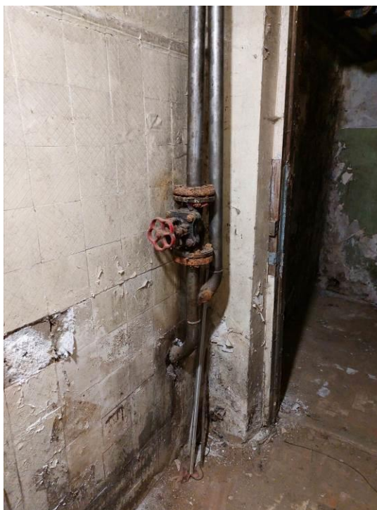
Фото 165. ЦИК, подвал, ввод водопровода и трубопроводы сплошная коррозия, задвижка в не рабочем состоянии.
