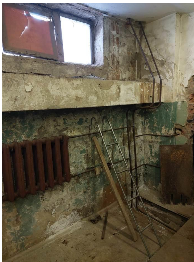
Фото 183. ЦИК, подвал, системы отопления, сплошная коррозия трубопроводов и радиаторов.
