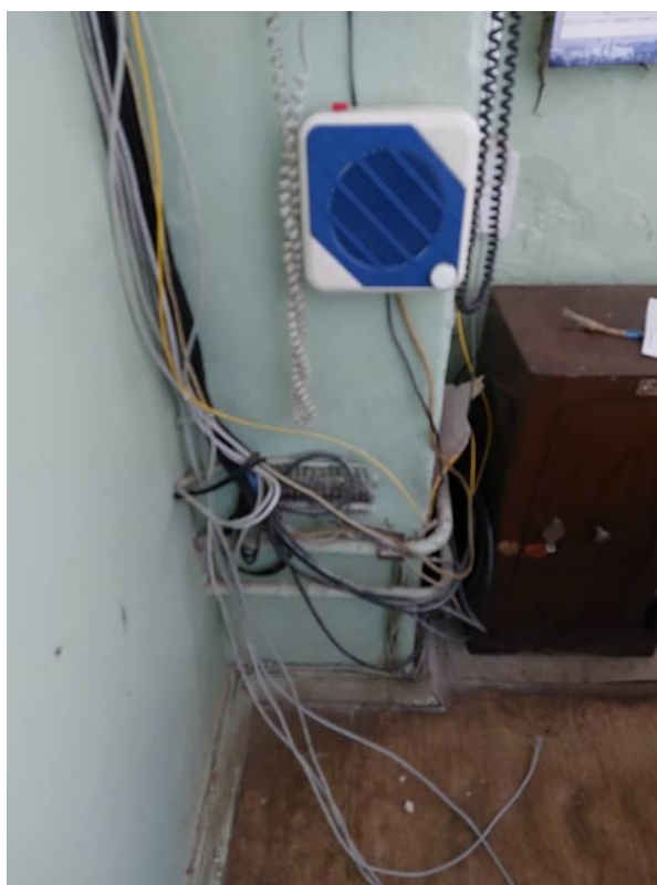
Фото 137. ЦИК, 2 этаж, кабельные трассы уложены с нарушением ПУЭ, отсутствуют кабельные бирки, имеются поврежденные и обесточенные кабели.
