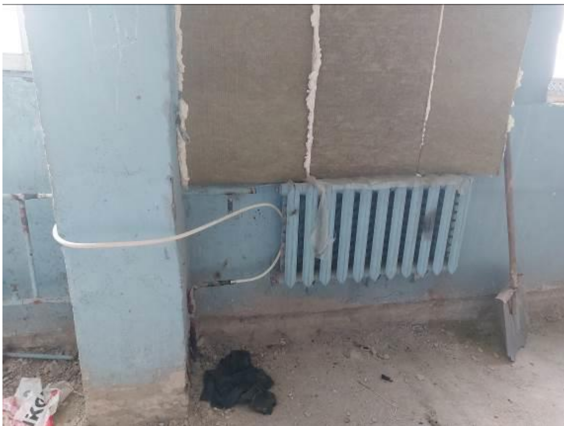
Фото 51. Пристройка ЦИК, 4 этаж, вент камера, радиатор срезан, система закольцована по временной схеме.
