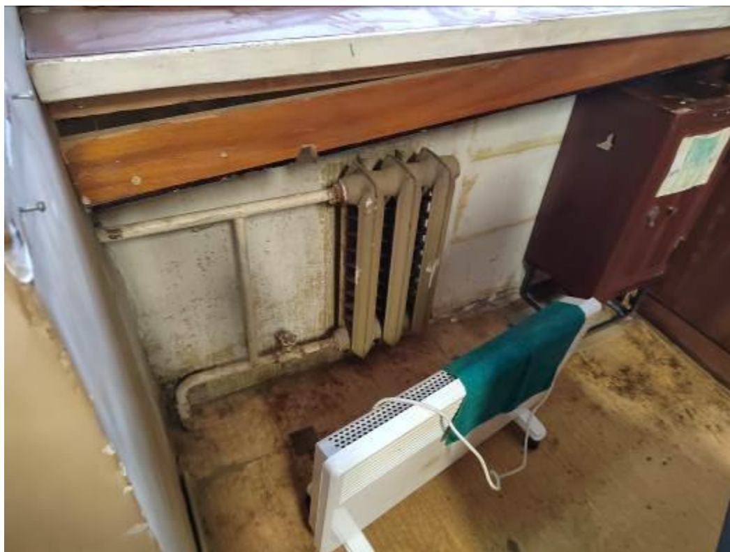
Фото 103. Пристройка ЦИК, 1 этаж, система отопления в ограниченно-работоспособном состоянии, имеются следы протечек, коррозия элементов системы, установлены электрические масляные обогреватели.
