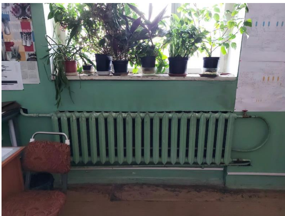
Фото 145. ЦИК, 1 этаж, коррозия трубопроводов, не рабочая запорно-регулирующая арматура.
