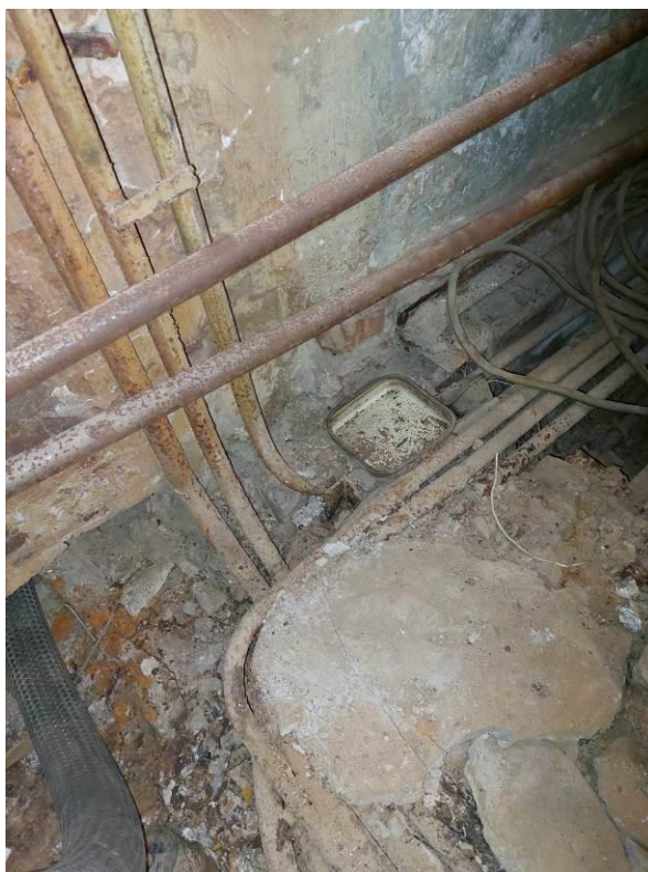
Фото 172. ЦИК, подвал, коррозия трубопроводов водоснабжения, не действующие сети электроснабжения.
