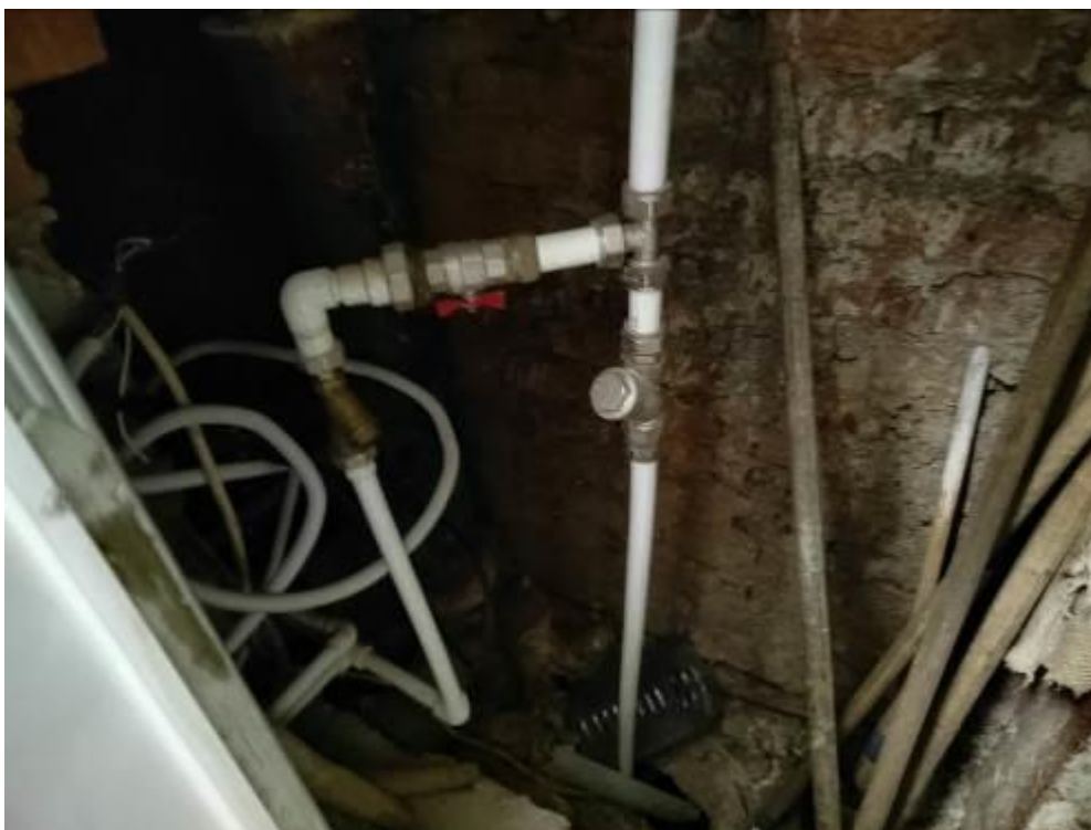
Фото 99. Пристройка ЦИК, 1 этаж, стояк систем водоснабжения и канализации, трубопроводы канализации имеют следы протечек, сплошную поверхностную коррозию, трубопроводы системы водоснабжения частично заменены на металлопластиковые.
