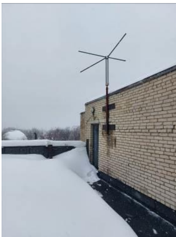
Фото 8. Кровля пристройки к ЦИК, выход на кровлю, молниеприемник и подсветка выхода.
