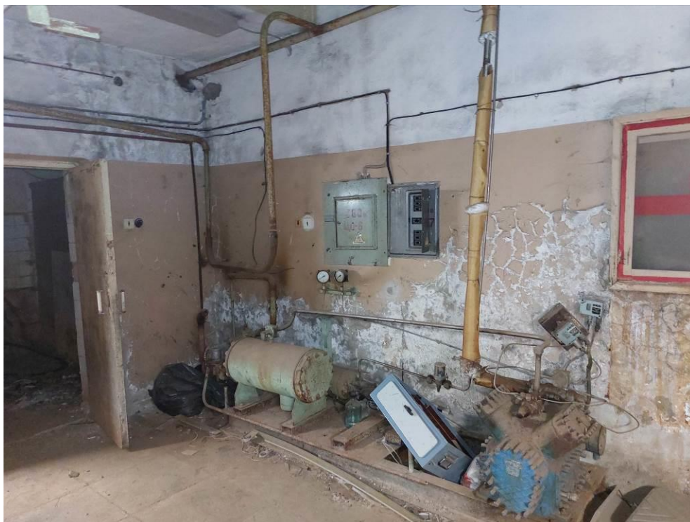
Фото 178. ЦИК, подвал, не рабочая компрессорная станция, коррозия трубопроводов, частично не работающие щиты электроснабжения.
