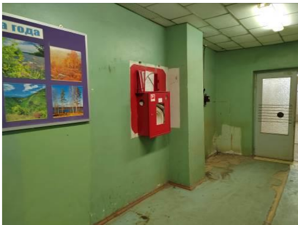
Фото 104. Пристройка ЦИК, 1 этаж, система противопожарного водопровода в не работоспособном состоянии.
