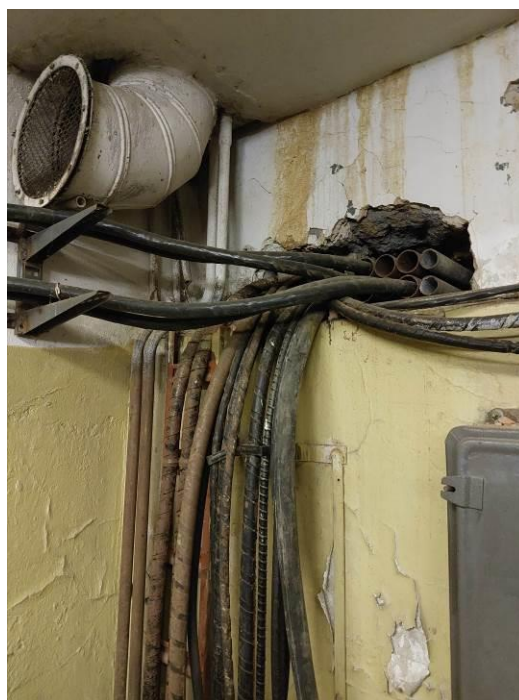
Фото 189. ЦИК, подвал, ввод кабелей от ТП-9, кабельные бирки отсутствуют, коррозия кабельной изоляции.
