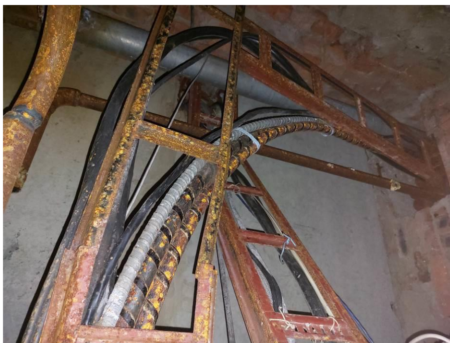
Фото 175. ЦИК, подвал, сплошная коррозия трубопроводов, опор, кабельной изоляции.
