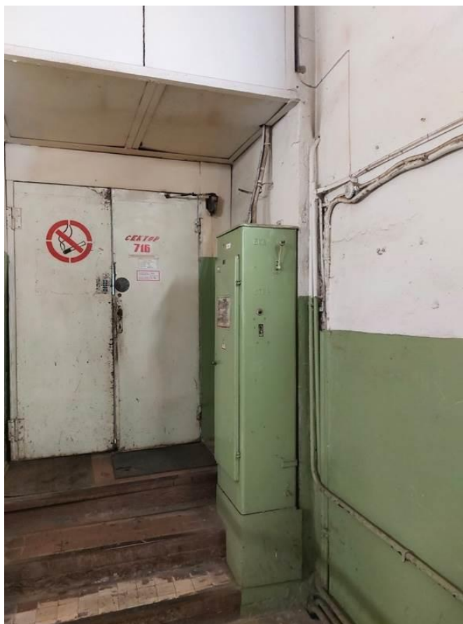
Фото 150. ЦИК, 1 этаж, щит распределительный.
