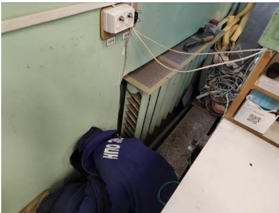
Фото 91. Пристройка ЦИК, 1 этаж, розетки силовые, сигнализации, срезанные кабели, подключение по временной схеме.
