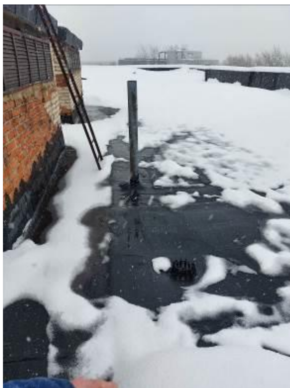
Фото 6. Кровля пристройки к ЦИК, фановый стояк х/б канализации, дождеприемная воронка ливневой канализации и не используемые вентиляционные шахты.
