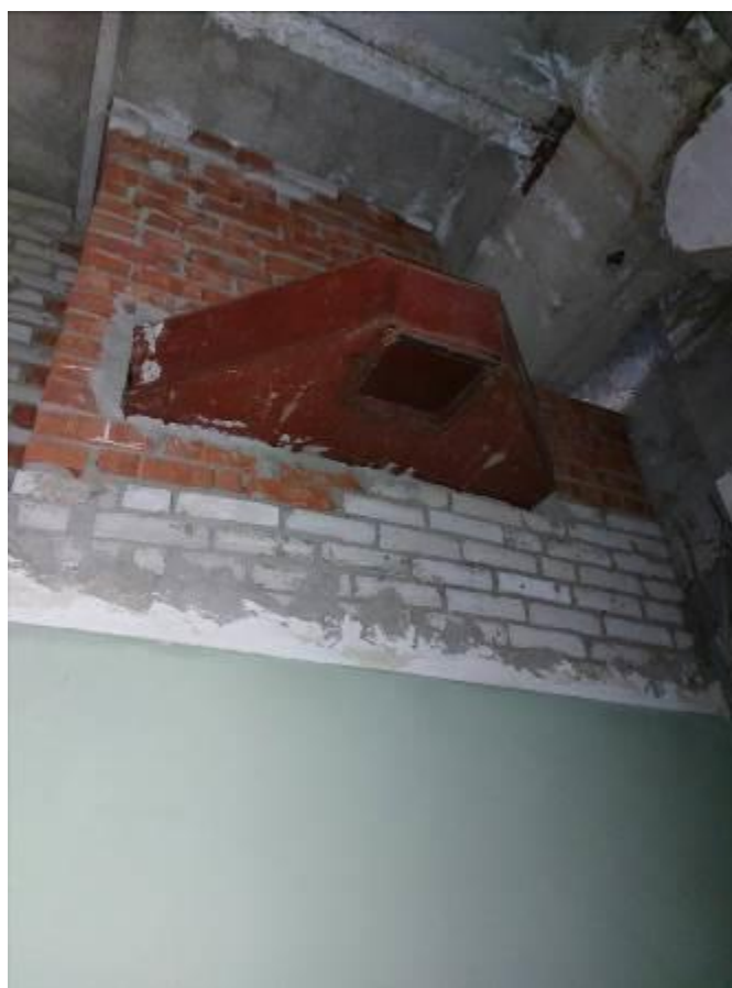
Фото 36. Пристройка ЦИК, 4 этаж, вентиляция в не работоспособном состоянии, выходы заглушены.
