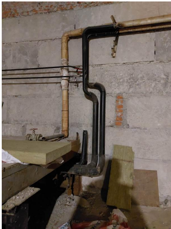
Фото 192. Пристройка к ЦИК, подвал, ремонтная вставка системы теплоснабжения.
