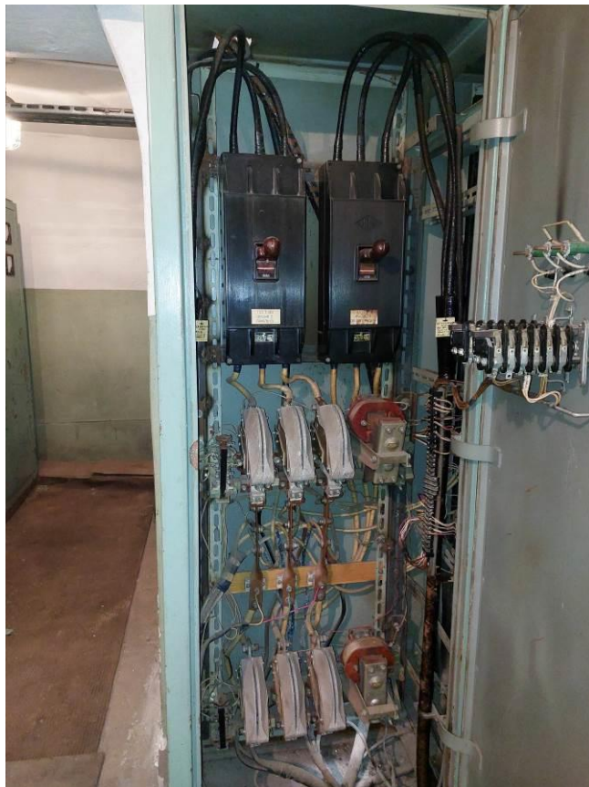
Фото 184. ЦИК, подвал, щиты АВР и распределительные, отсутствуют кабельные бирки, частично разукomплектованы, частично не работают, частично отключены.
